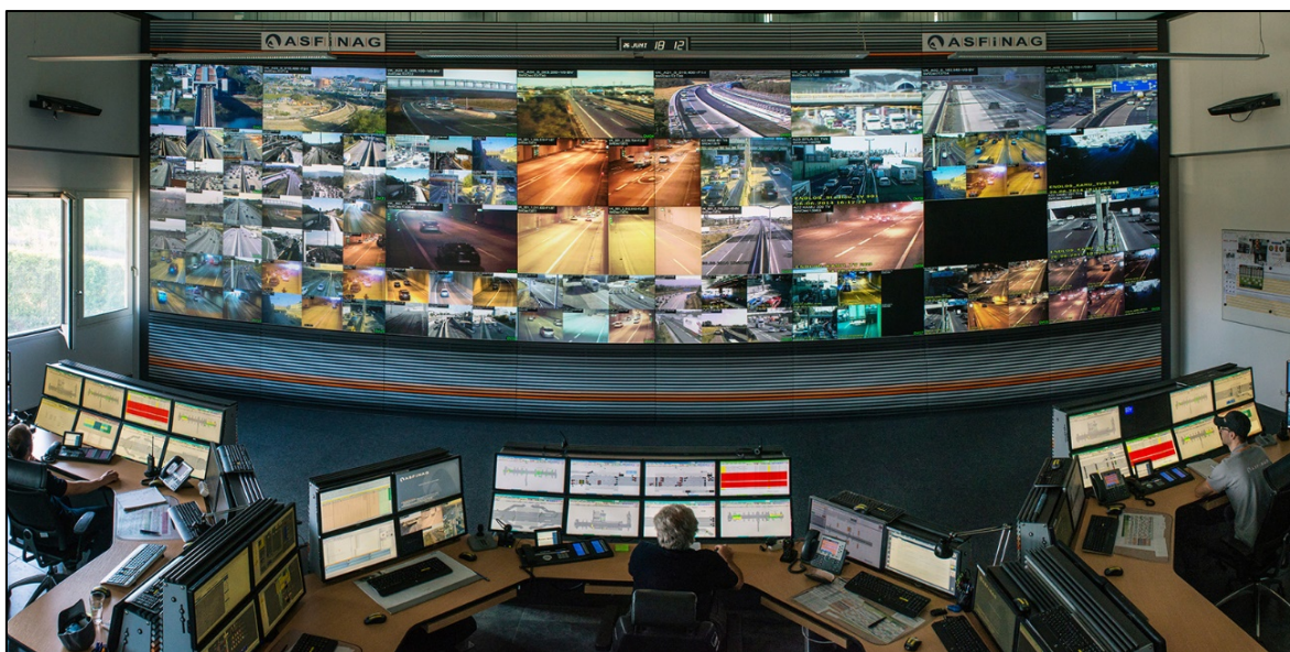
Abbildung 12: Asfinag Verkehrsmanagementzentrale Wien, Inzersdorf, Quelle: Archiv Asfinag
