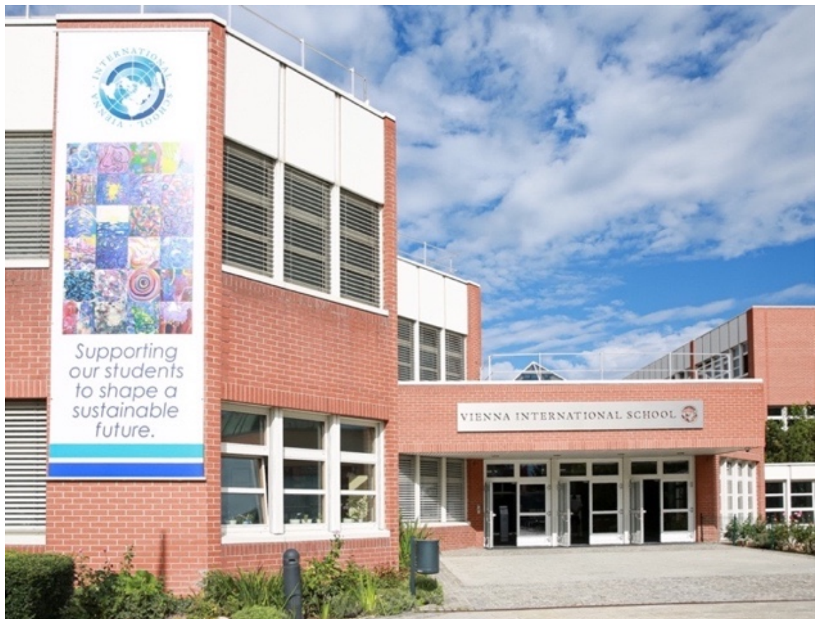
Abbildung 10: Schulgebäude Vienna International School
