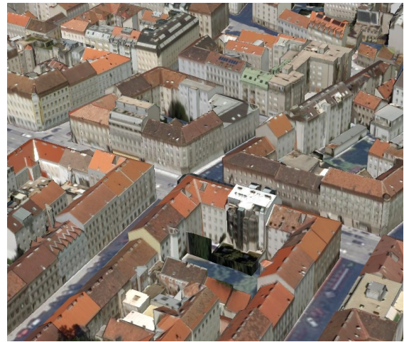
Abbildung 80: Sonnenseite von Gebäuden (Quelle: Stadt Wien intern).
