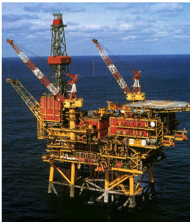
Zdjęcie 3. Platforma wiertnicza
