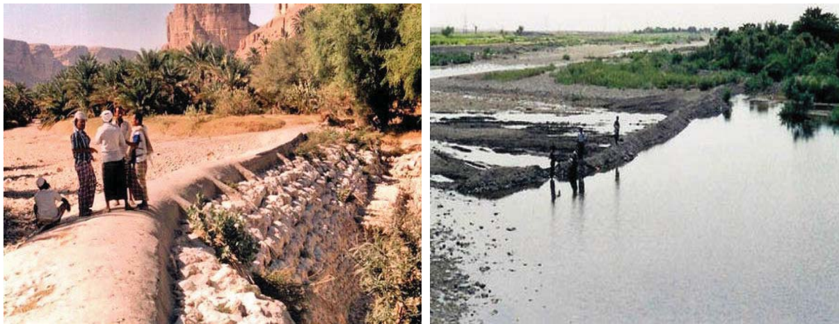
Abb. 12: Ablenkdam vom Typ qayd im Wādī Ḥaḍramawt und ‘uqma im Wādī Tuban 78
