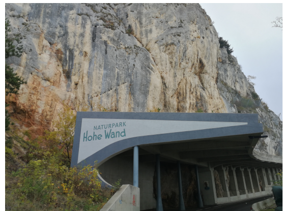
(b) Galerie zum Schutz einer Straße bei Maiersdorf, Niederösterreich.
