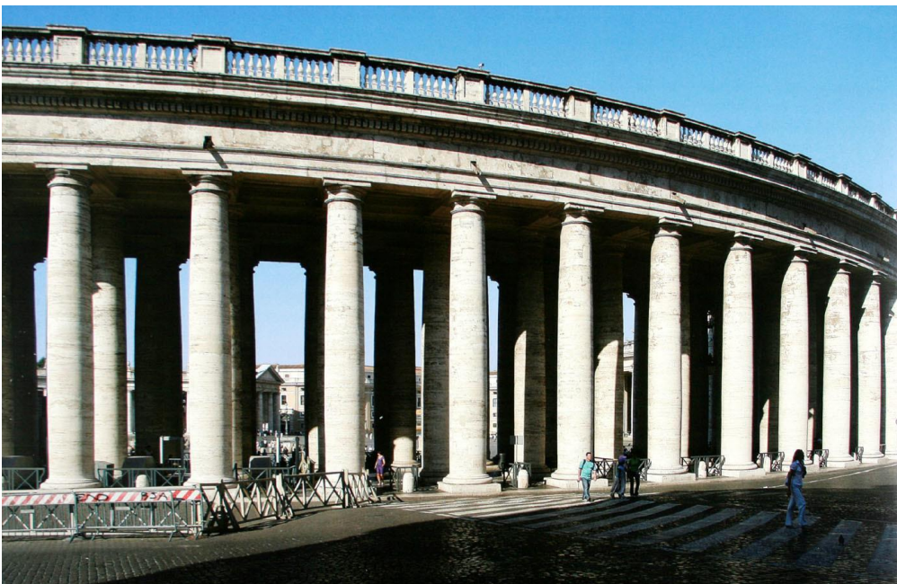
Abb. 36: Südliche Kolonnaden auf dem Petersplatz.
