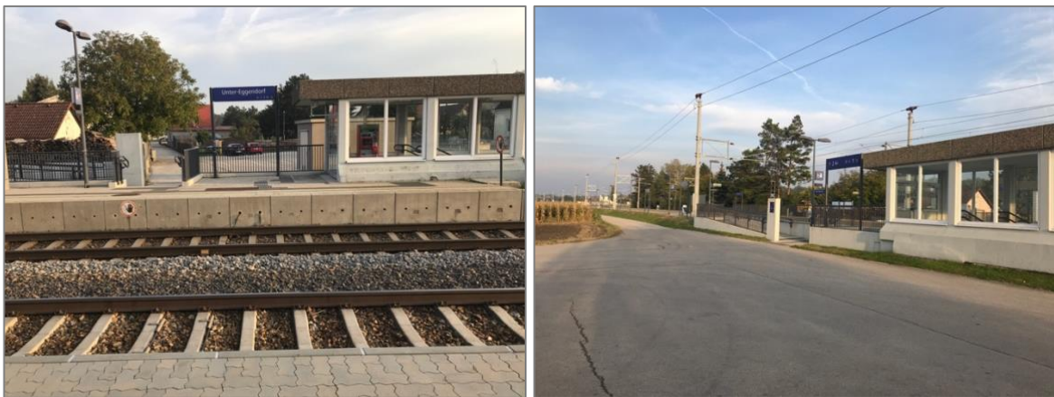
Abbildung 65: Bahnhof Untereggendorf, Quelle: eigene Aufnahmen
