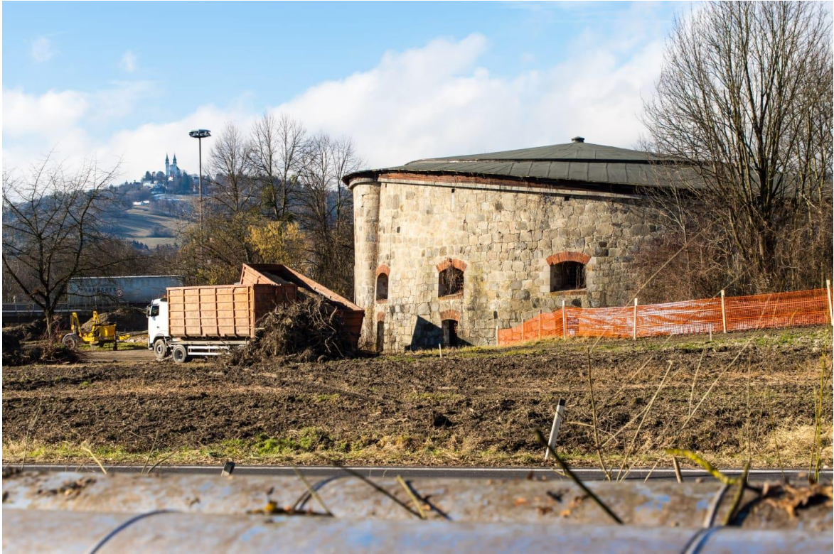
Abbildung 18: Turm 24 – Seitenansicht mit Blick auf Pöstlingberg 483
