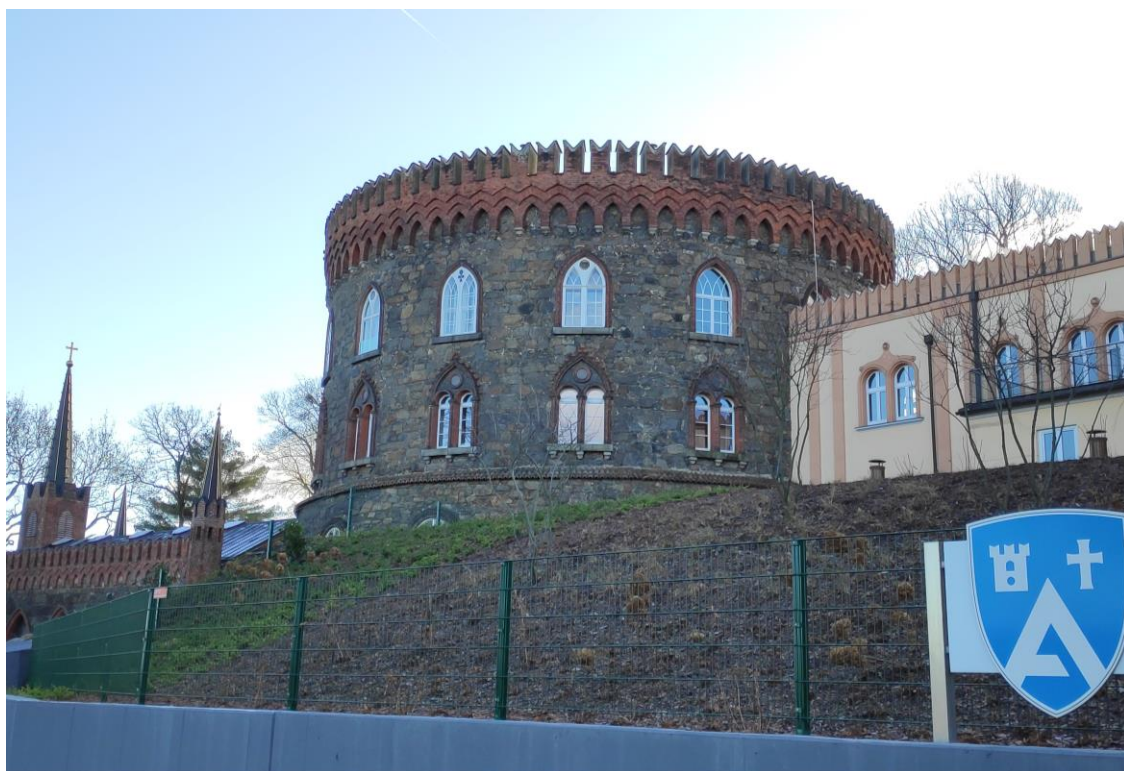
Abbildung 23: Probeturm neben Kirche und Seminargebäude 521
