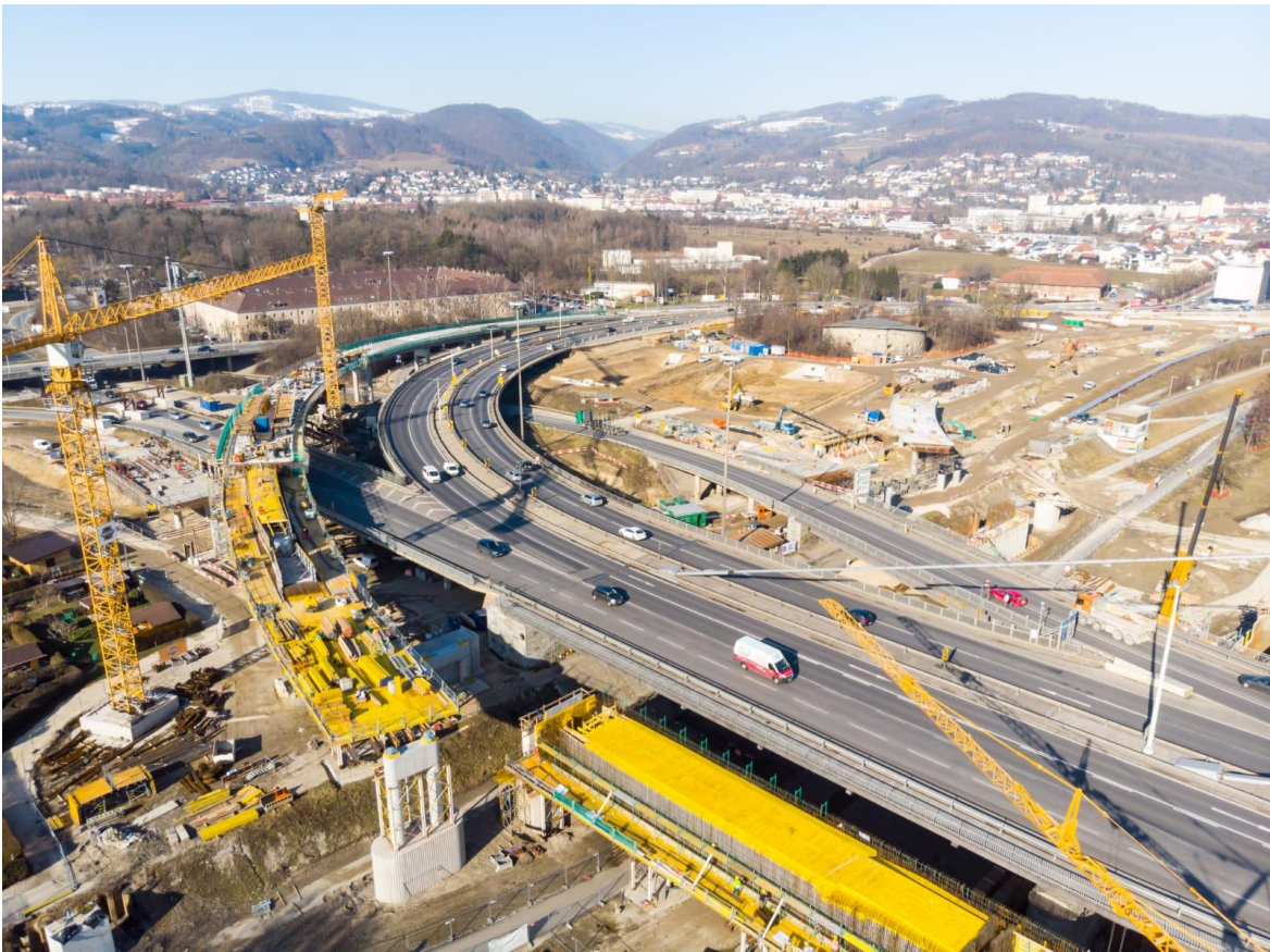
Abbildung 17: Turm 24 und Umfeld – Luftbild 480
