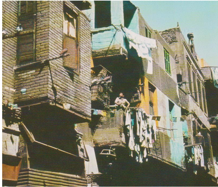
Abbildung 27 Schlechte Wohnsituation in Teilen der Stadt Kairo in den 1970er Jahren; Quelle: MEYER G. 2004: 132
