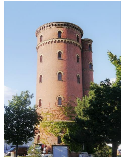
Abbildung 20: Leuchtturmprojekt Wasserturm. Foto: Gebhardt
