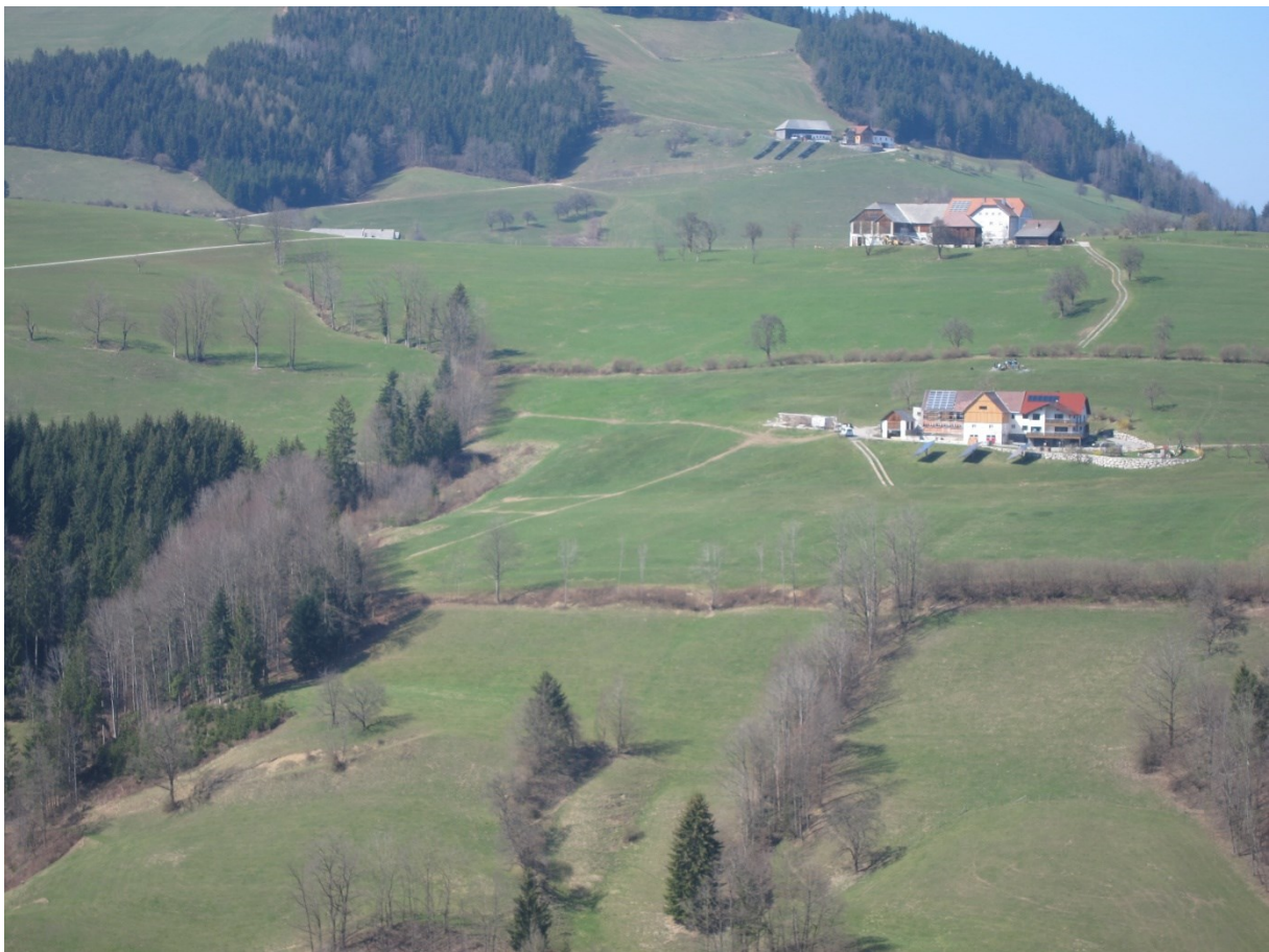
Abbildung 4: Hofermühle-Rutschung vom gegenüberliegenden Hang (eigene Aufnahme, 29.03.2019)
