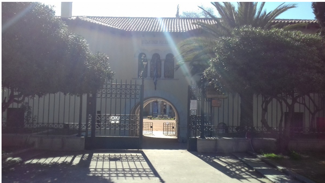
Abb. 11 Byz. Museum. Fassade Nord des nördlichen Bauteils.
