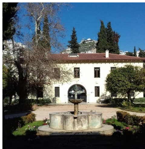
Abb. 9 Byz. Museum. Blick auf dem nördlichen Bauteil
