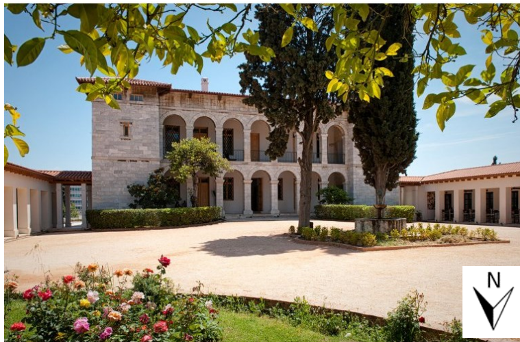
Abb. 8 Byz. Museum. Pfeilerkolonnade und Peristyl.
