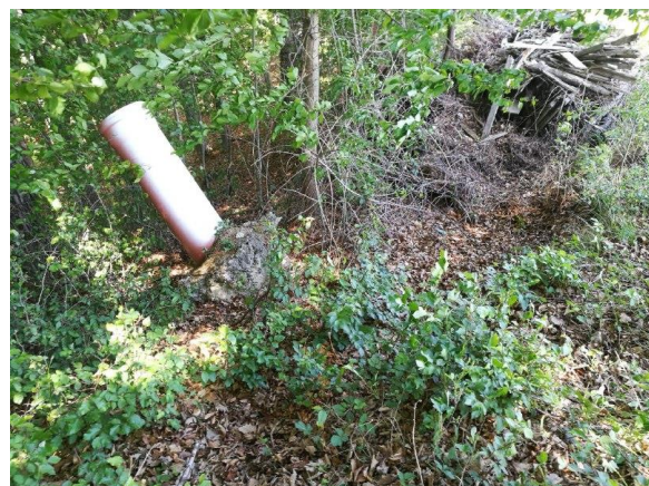
Abbildung 16 - Rutschung Wilhelmsburg – Messpfeiler – eigene Aufnahme
