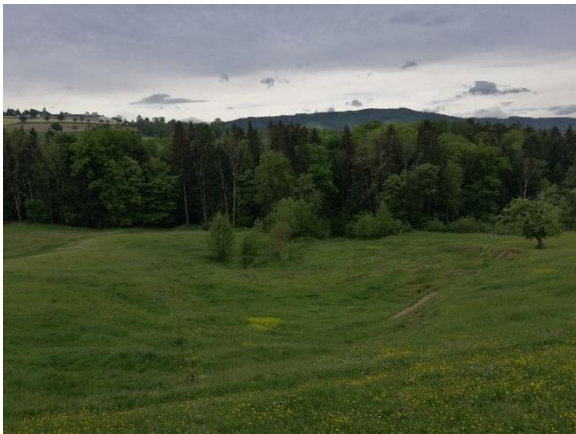
Abbildung 13 - Rutschung Behamberg – oberer Bereich der Rutschung - eigene Aufnahme
