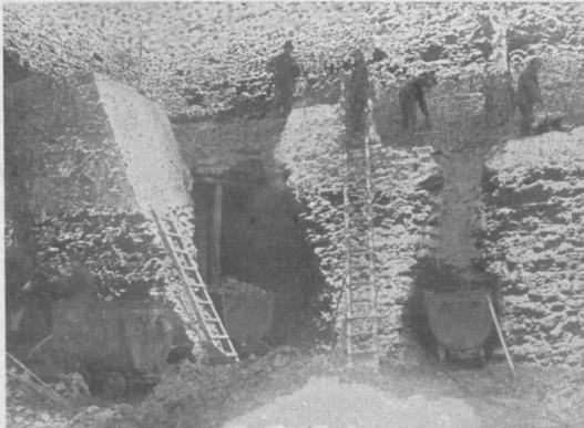
Ausschnitt eines Stigges und Gewinnung der Kohle im Neufelder Tagbau.
