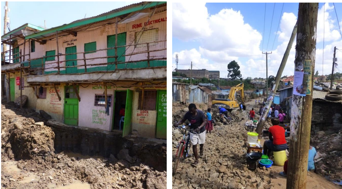
Abbildung 13 Erschwerte Zugänglichkeit von Läden und Häuser (l.) Straßenverkauf während der Bautätigkeiten (r.) / Foto Autorin 2016
