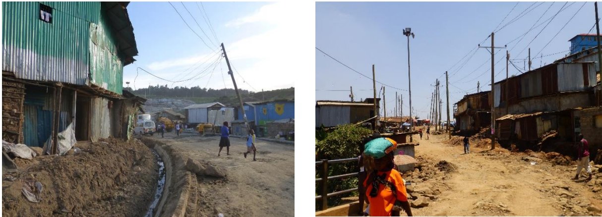
Abbildung 11 Strompfosten ragen nach den Rückbauten in die Straße / Autorin 2016
