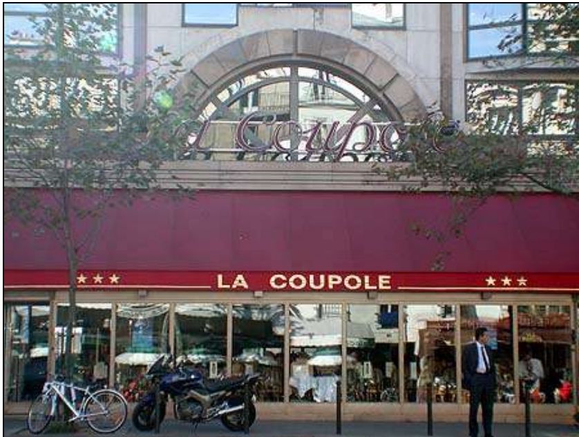
Abbildung 31 La Coupole, Außenansicht
