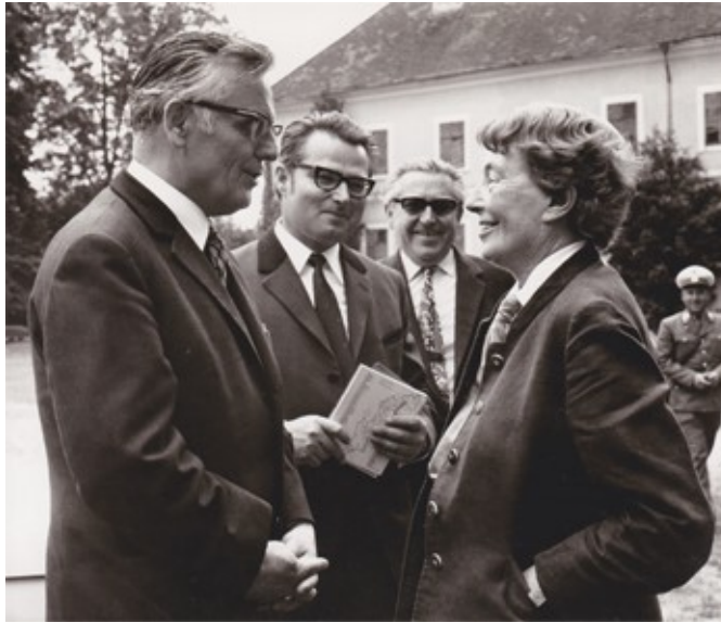
Abbildung 45: Dachstuhlbegehung mit LH Kery, 1975.
