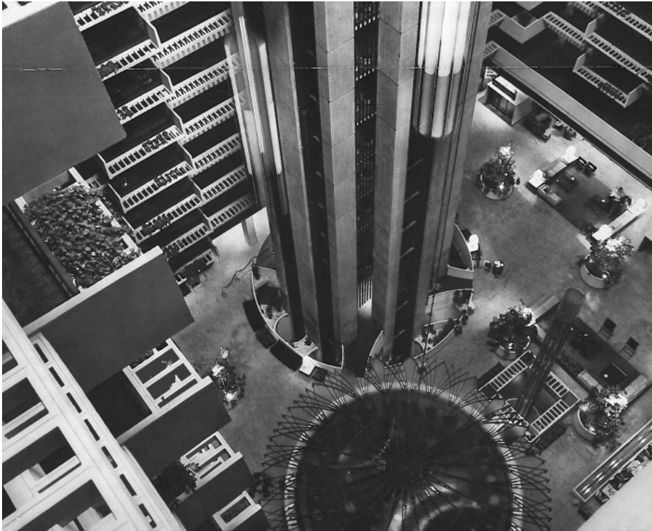
Abbildung 35: John Portman, Hyatt Regency Atlanta , Turm und Fahrstuhlschächte, 1967
