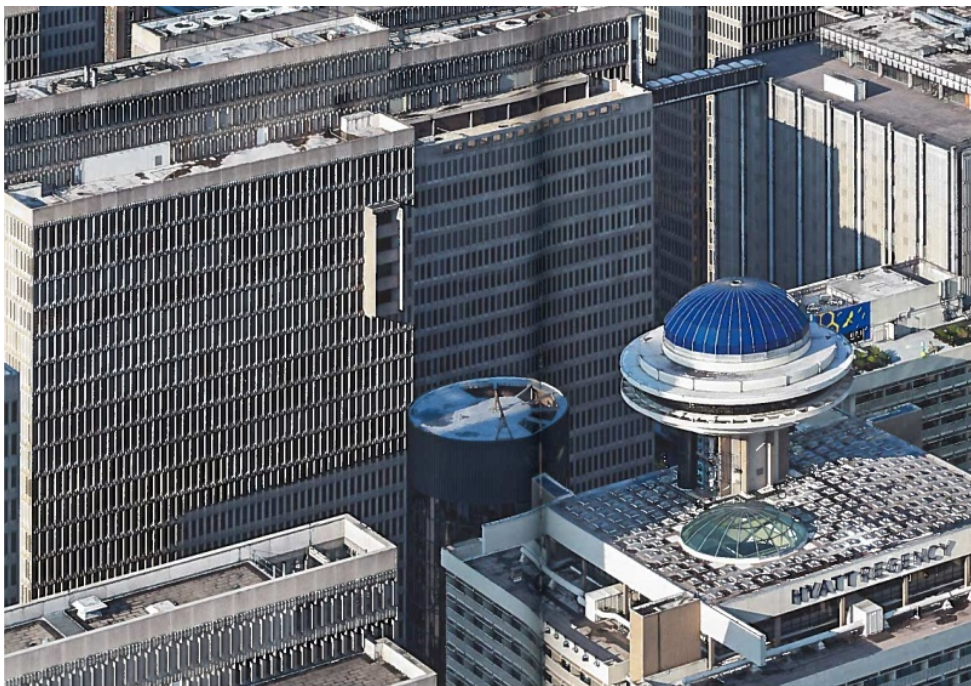
Abbildung 30: John Portman, Hyatt Regency Atlanta , Sicht auf das Dach, 1967
