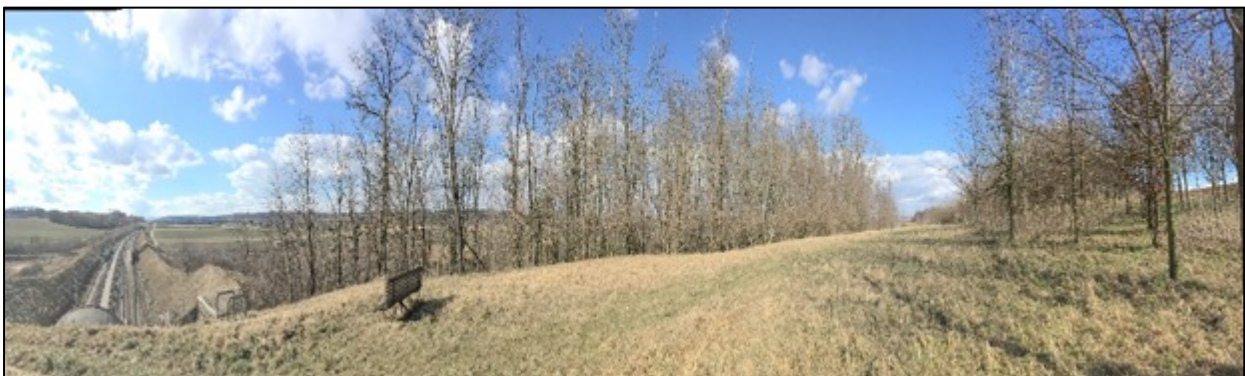
Abbildung 31: Aufnahme einer ÖAF auf dem Grüntunnel Hankenfeld (Quelle: Eigene Aufnahme, 2018)
