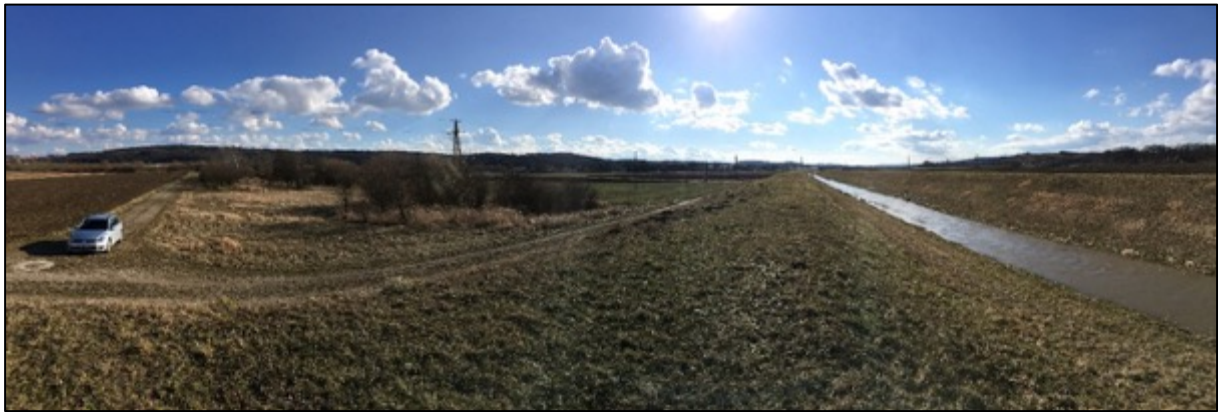
Abbildung 23: Sicht vom Perschlingkanal auf ÖAF Gemeinde Michelhausen (Quelle: Eigene Aufnahme, 2018)
