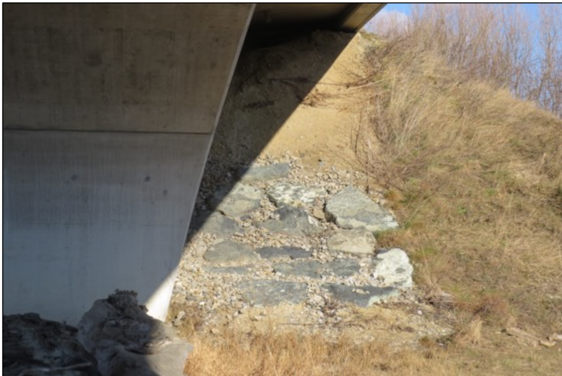
Abbildung 21: Wildtierunterführung Michelhausen (Quelle: Eigene Aufnahme, 2018)
