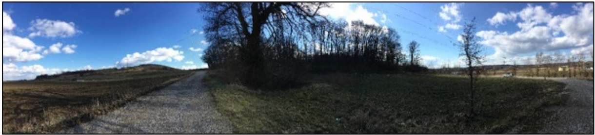
Abbildung 27: Übersichtsaufnahme ÖAF Grüntunnel Hankenfeld (Quelle: Eigene Aufnahme, 2018)
