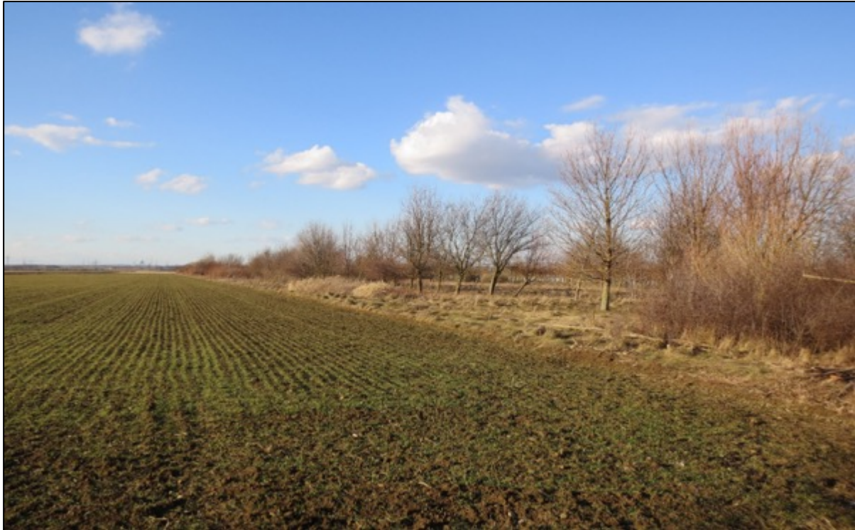
Abbildung 46: Übersichtsaufnahme ÖAF Wildtierunterführung Kleine Tulln (Quelle: Eigene Aufnahme, 2018)
