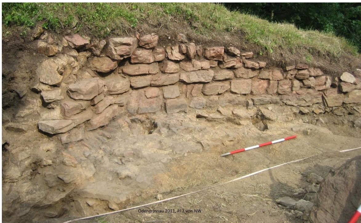
Abbildung 34: Ansicht des inneren Mauerknicks in Fläche 7 aus Nordwesten. Foto: S. Felgenhauer-Schmiedt
