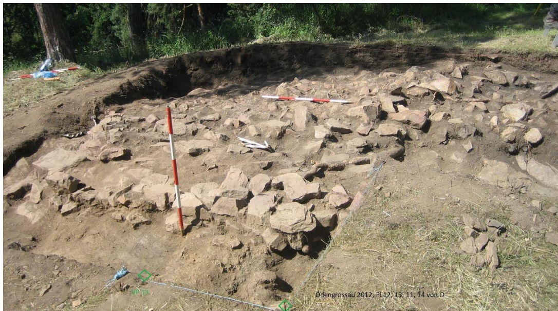
Abbildung 41: Trockensteinfundament eines Gebäudes im Westen der Grabungsfläche. Foto: S. Felgenhauer-Schmiedt
