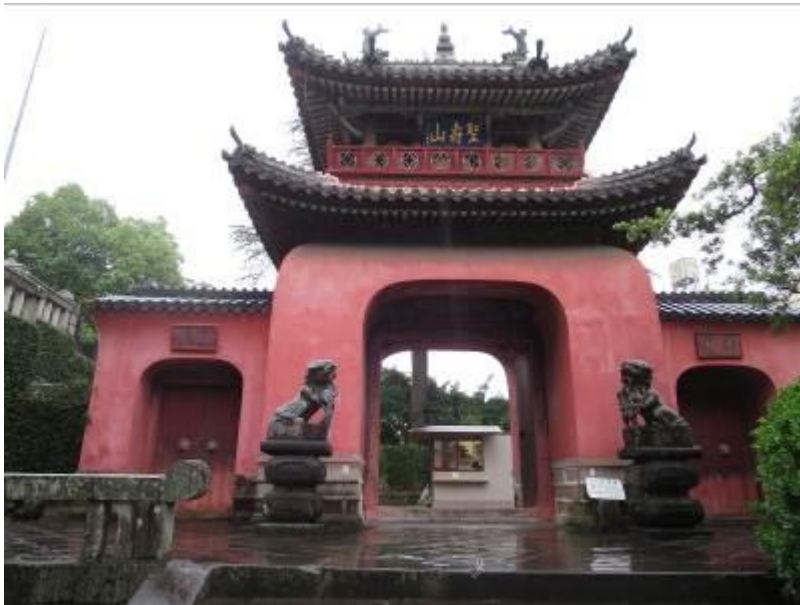
Abb. 42: Eingang des Daion-ji © Tu, 2015
