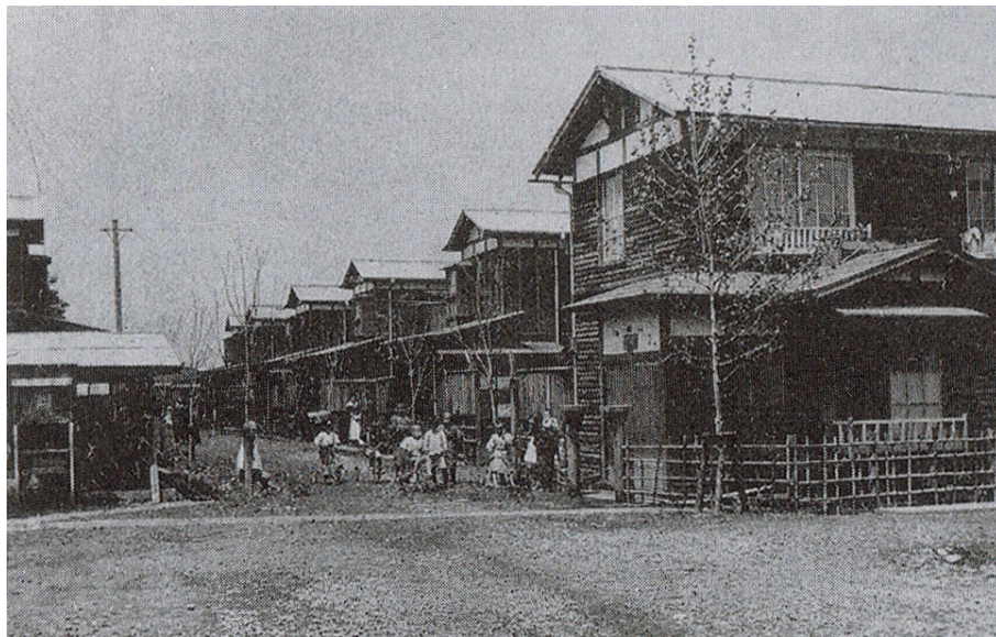
Abbildung 6: Siedlung mit Holzmietwohnungen in Jūjō
