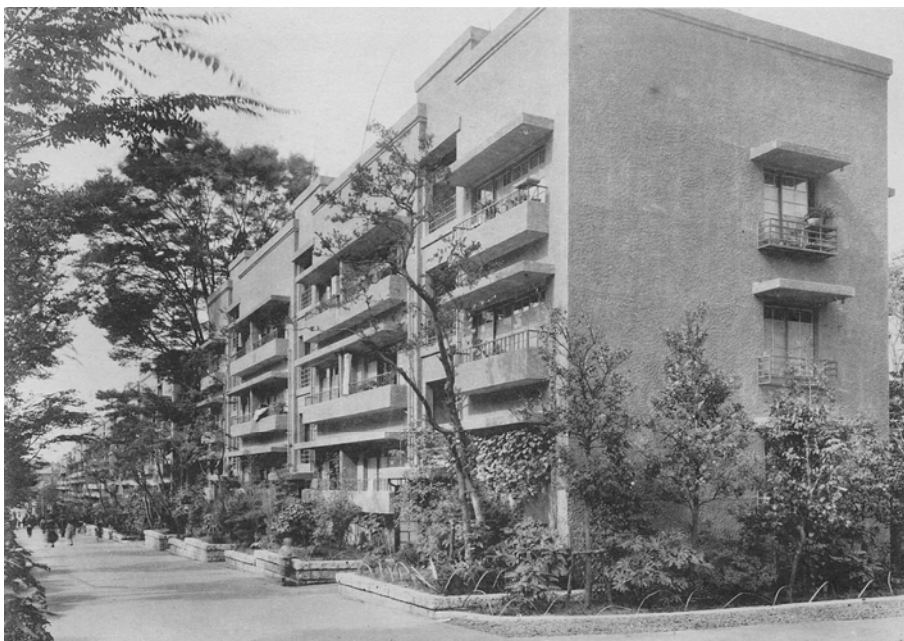
Abbildung 10: Blick auf die Aoyama Apartments
