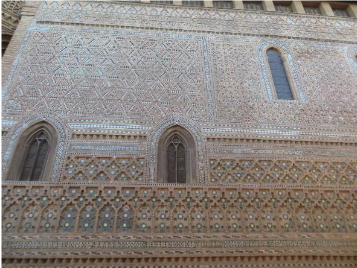
Taf. 96: Iglesia catedral la Seo, nordöstliche Außenfassade, mudéjare Wandgestaltung, 1378-79, Zaragoza.
