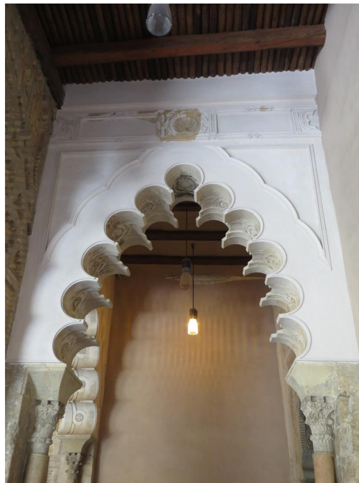
Taf. 49: Aljafería, Nordteil, Arkadendurchgang vom östlichen Seitenraum des Hauptraums zum nordöstlichen Eckraum.
