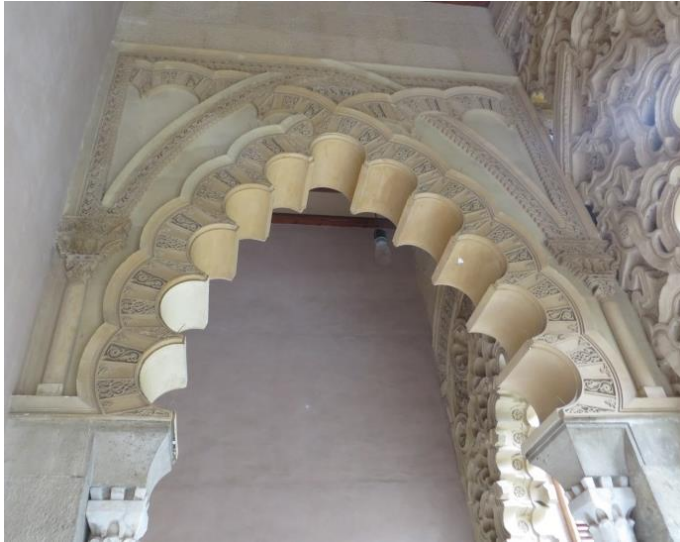
Taf. 70: Aljafería, Südteil, Arkadendurchgang vom Durchgangsbereich zum westlichen Seitenraum.
