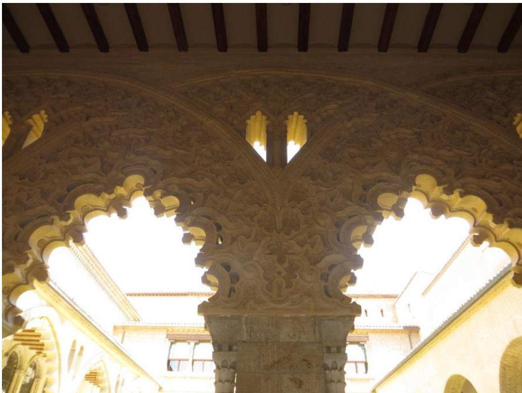
Taf. 59: Aljafería, Südseite, Arkadendurchgang des südlichen Portikus, Rückseite.
