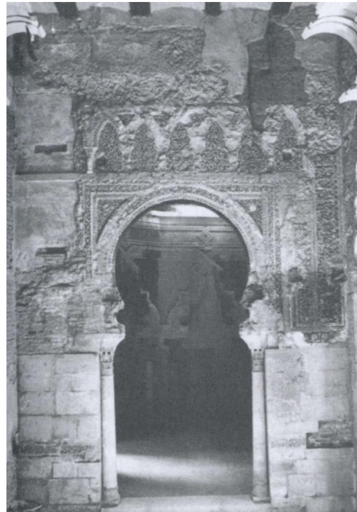
Taf. 27: Aljafería, Nordteil, Eingang zum Betraum, 1966.
