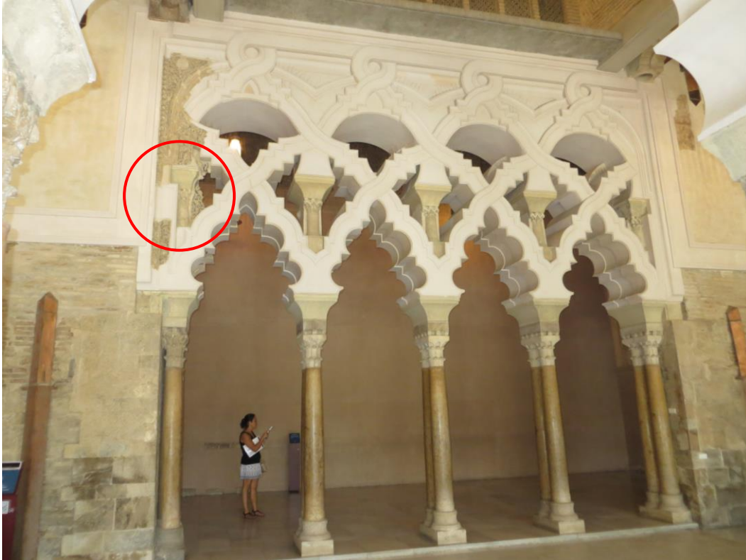
Taf. 64: Aljafería, Nordteil, Eingang zum Thronsaal. (Markierung von Verfasserin)
