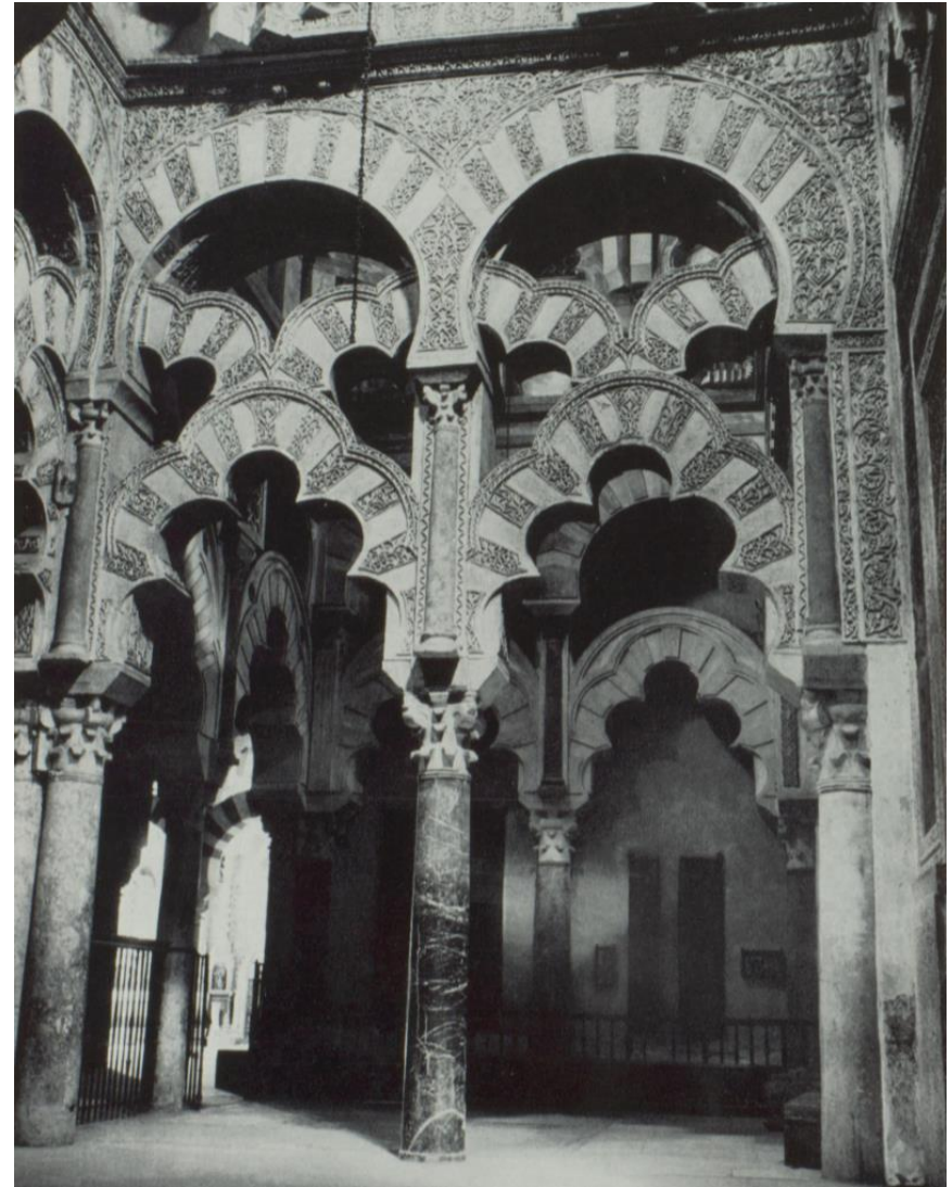
Taf. 78: Mezquita, Vor-Mihrab-Bereich, östlicher Arkadendurchgang, Rückseite, Córdoba.
