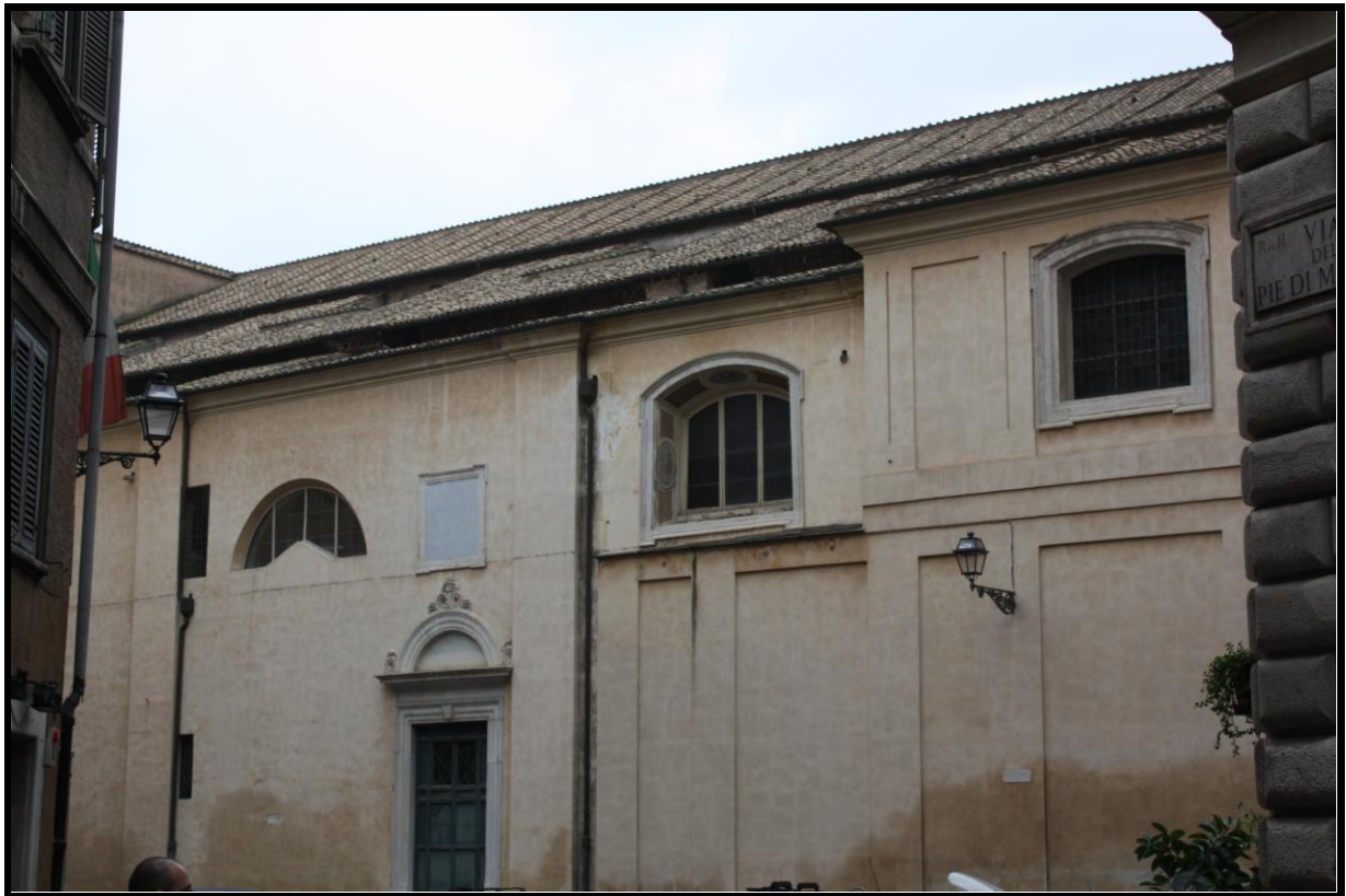
Abb. 52: Santa Maria sopra Minerva, Südliches Seitenschiffassade, 2009.
