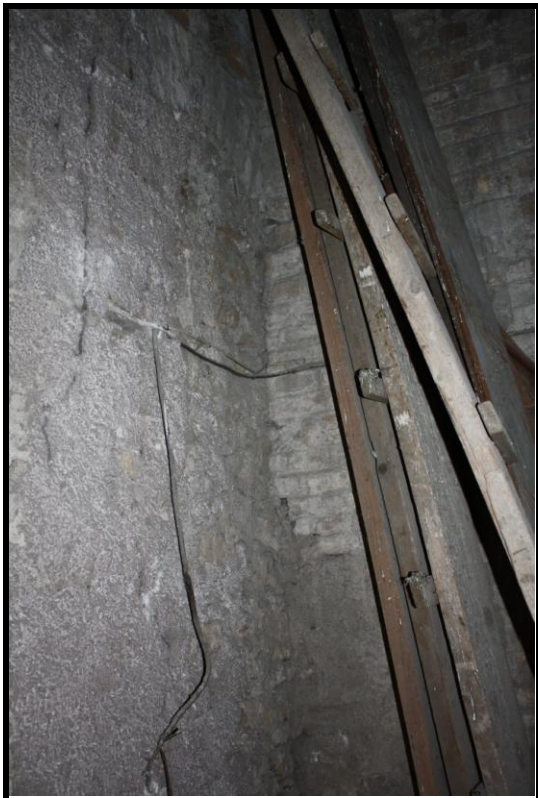
Abb. 66: S. Maria sopra Minerva, vermauertes Fenster über dem nördl. Seitenschiff zum Mittelschiff, 6. Joch, 2009.
