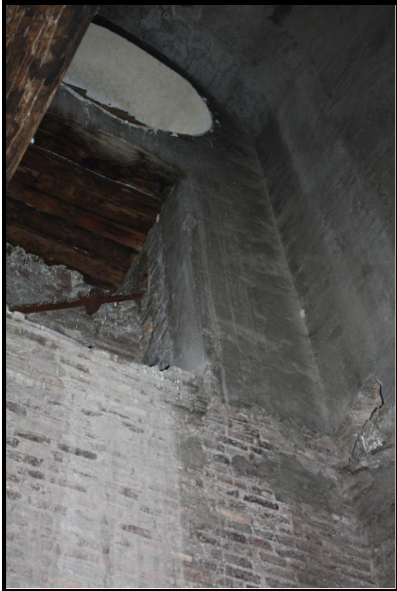
Abb. 96: S. Maria sopra Minerva, ehemalige Campanile nordwestliches Querhaus, 2009.
