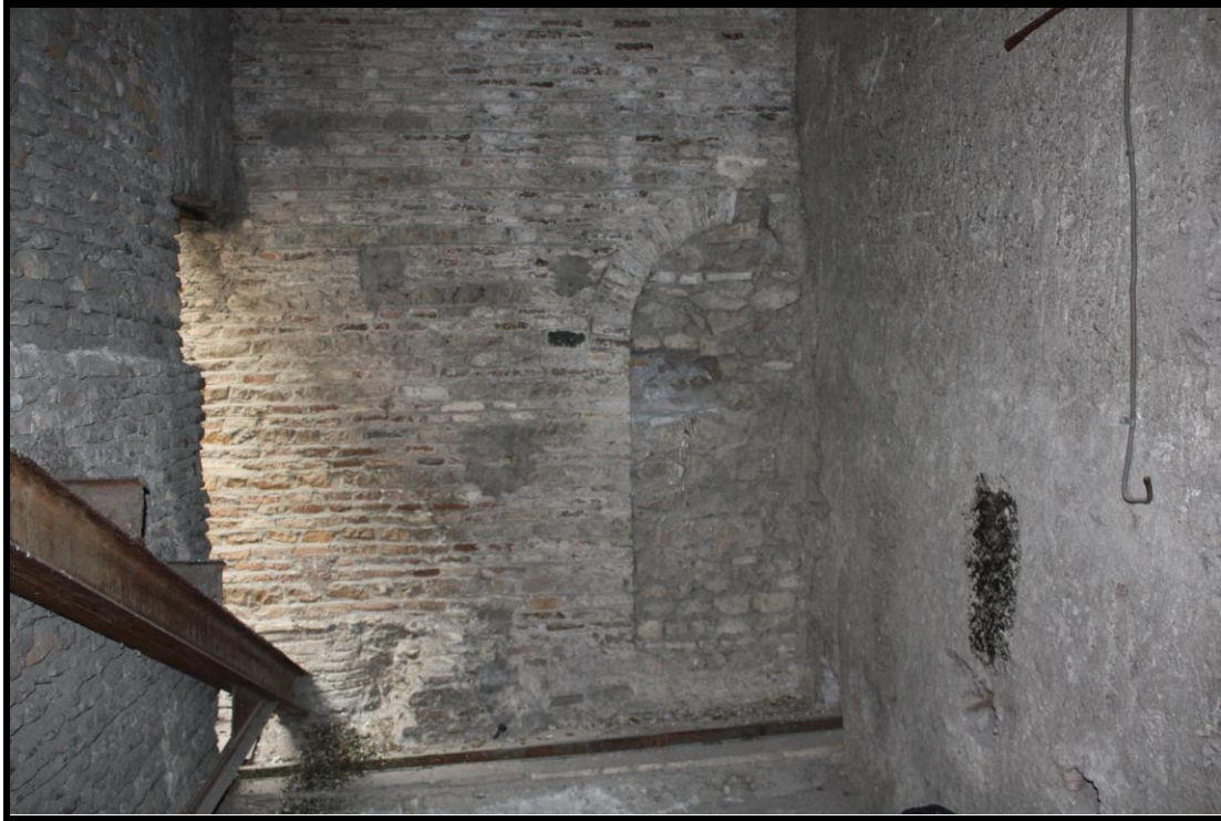
Abb.67: S.Maria sopra Minerva, vermauertes Fenster, nördliches Seitenschiff zum Mittelschiff, 1. – 2. Joch, 2009.
