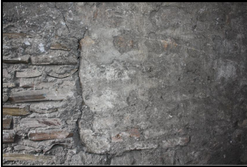
Abb.69: S. Maria sopra Minerva, vermauertes Fenster, nördliches Seitenschiff zum Mittelschiff, 2.-3.Joch, 2009.
