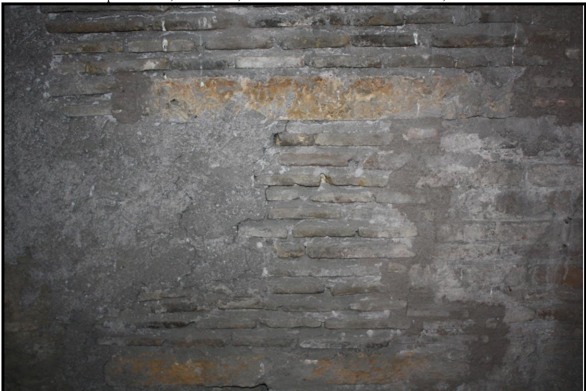
Abb. 64: S. Maria sopra Minerva, Tuffblöcke über dem Gewölbe, südliche Mittelschifftonne, 1m vor der Fassade, 2009.
