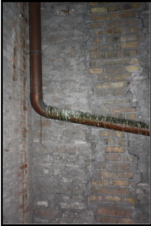
Abb.65: S. Maria sopra Minerva, vermauertes Fenster über dem südlichen Seitenschiff zum Mittelschiff, 6.Joch, 2009.
