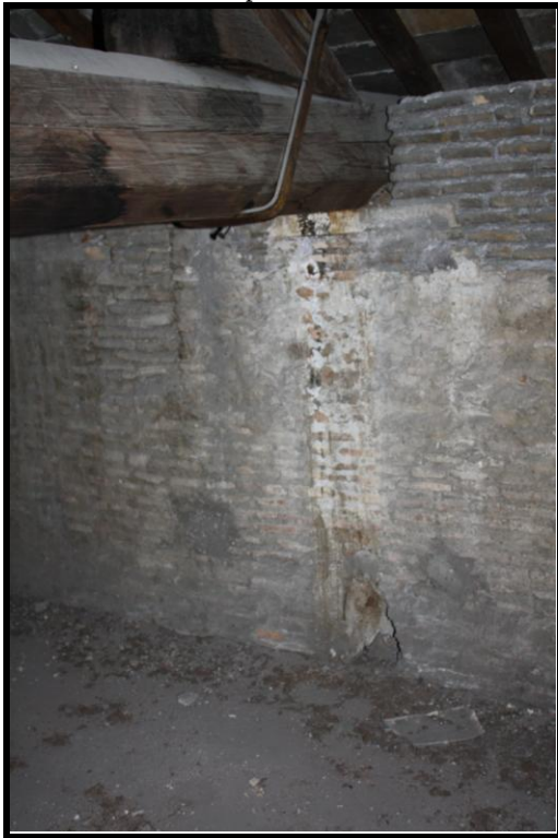
Abb.62: S. Maria sopra Minerva, Mauer über dem Gewölbe, südliches Langhaus, 2009.
