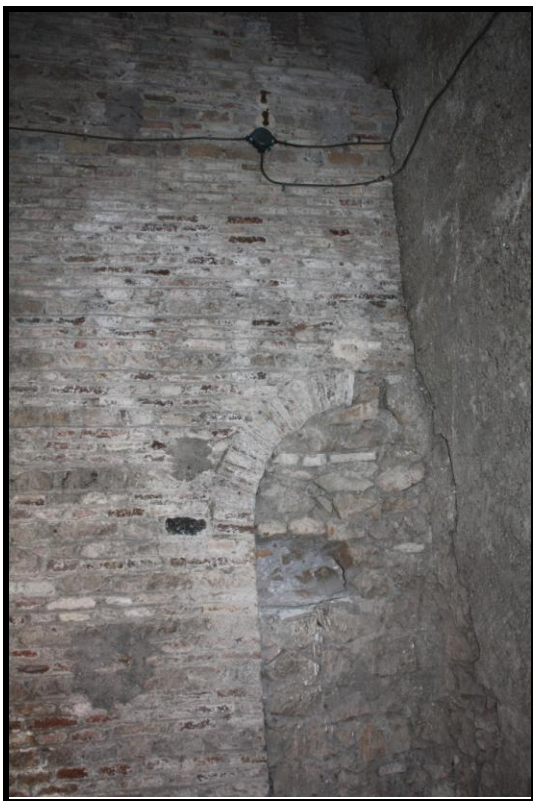
Abb.68: S. Maria sopra Minerva, vermauertes Fenster, nördliches Seitenschiff zum Mittelschiff, 2. – 3. Joch, 2009.
