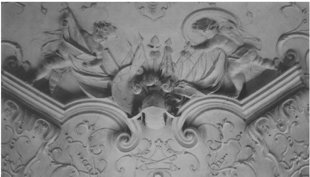
Abb. 43: Stuckdecke im Oberen Belvedere
