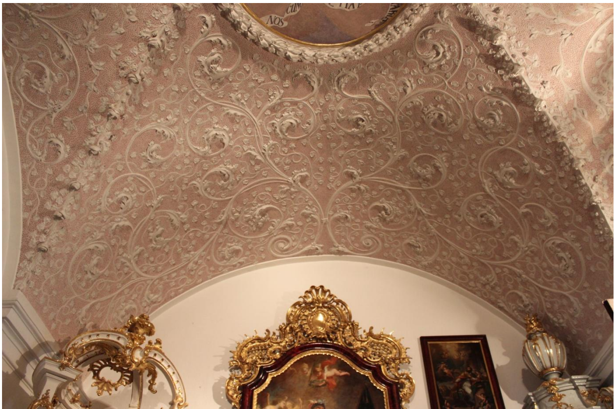
Abb. 4: Stuckiertes Tonnengewölbe mit Stichkappen, Bischöfliches Oratorium St. Pölten, um 1700–1710
