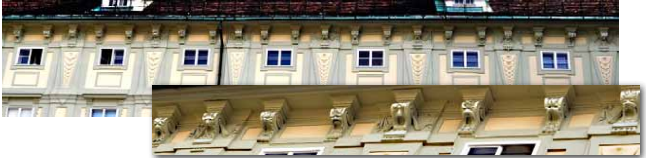
Abb. 41 Leopoldinischer Trakt, Nordseite und Fensterverdachung
