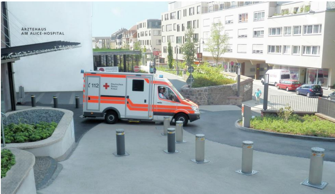
Abb. 35: Beispielhafte Sicherung eines Krankenhauses mittels versenkbarer Boller
