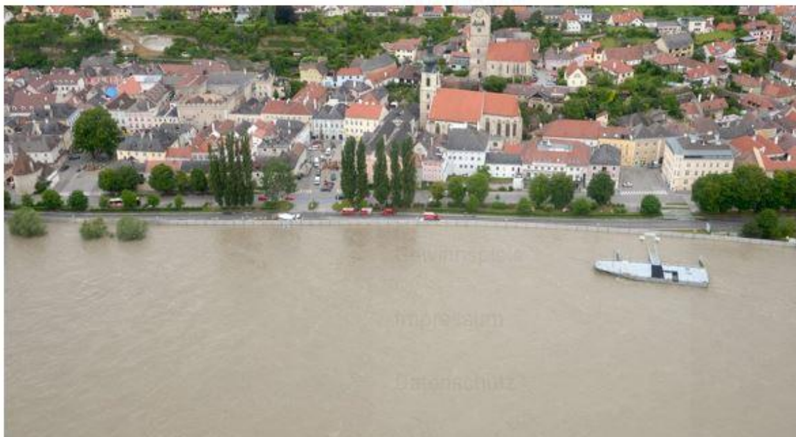
Abb. 14: Mobiler Hochwasserschutz Krems
