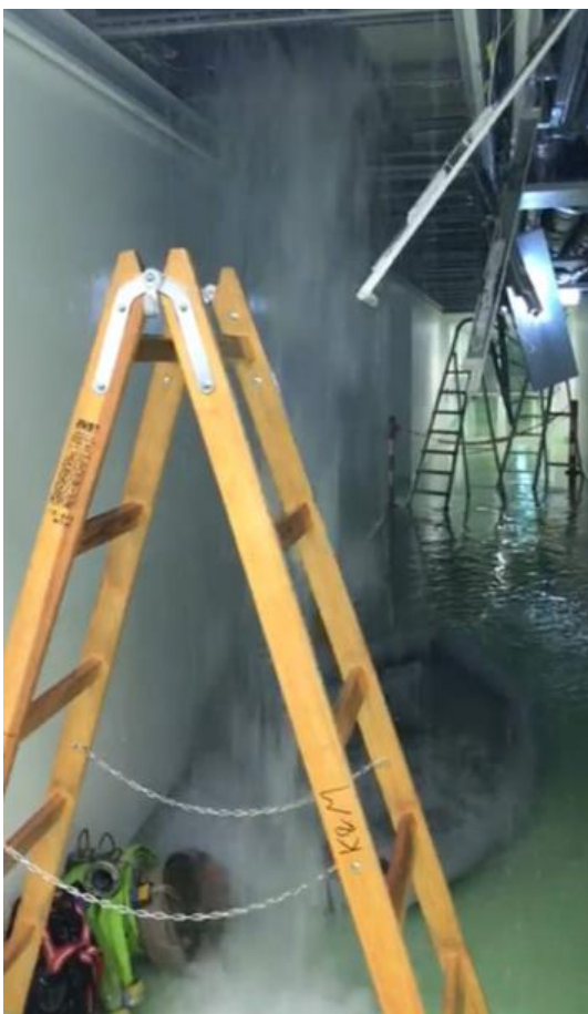
Abb. 45: Wasserschaden im LKH Baden
