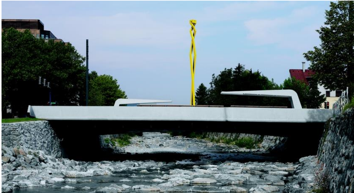
Abbildung 4: In der Mitte des Bildes die sogenannte "Do.Helix" von Hubert Lampert. (Quelle: https://zv-architekten.at/bauherrenpreis-1/bauherrenpreis-nominierung-2017/bauherrenpreis-2017-nominierte-projekte/v_saegerbruecke/@images/b0dea527-dd1e-4a47-804c-adacaa2553bc.jpeg - zuletzt eingesehen am: 20.04.2018)
