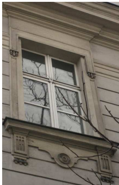
Abb. 159: 2. Mezzaninfenster, rückwärtige Fassade
