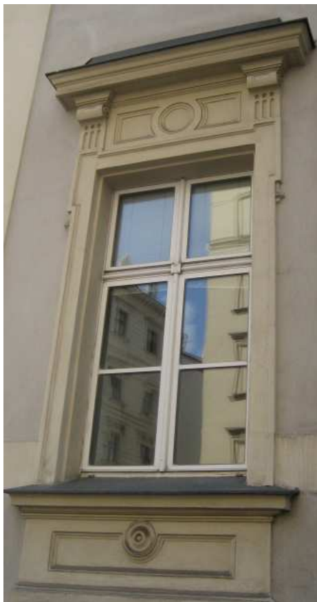
Abb. 155: 2. Beletagefenster, rückwärtige Fassade
