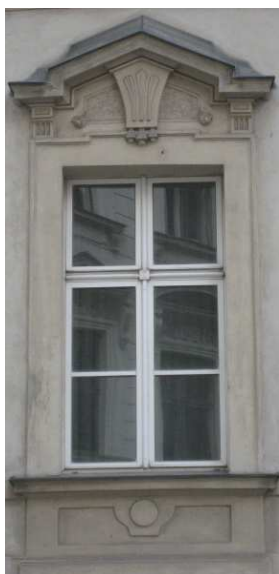
Abb. 160: Fenster des 1. Stockes, Rundung
