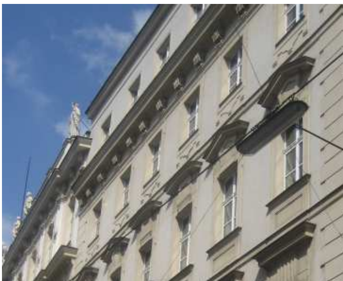
Abb. 144: Übergang des aufgestockten Geschosses zum Biliothischen Stiftungshaus
