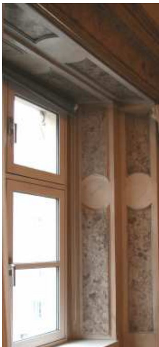
Abb. 141a: Fensterlaibung im Festsaal
