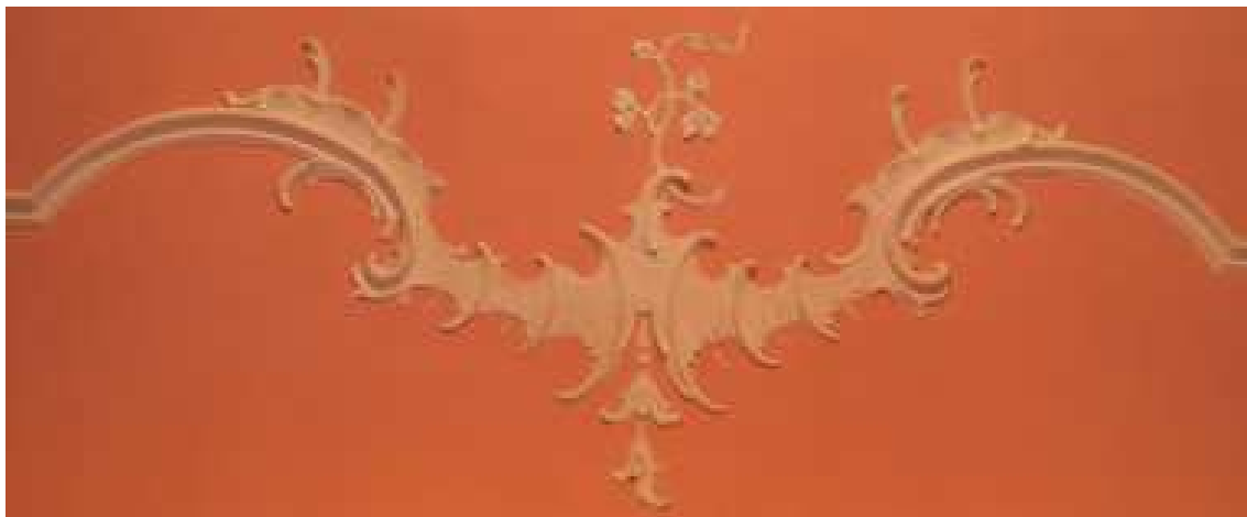
Abb. 127b: Stuckdetail in Raumfolge des 1. OG rechts entlang des großen Innenhofes
