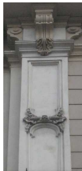
Abb. 145: Pilaster am aufgestockten Geschoss der Singerstrassenfassade
