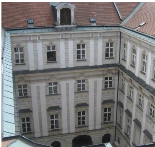
Abb. 85a: Fassade gegenüber der Hofstirnseite
