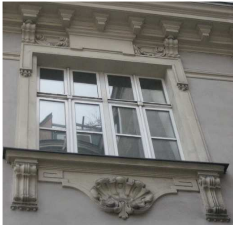
Abb. 157: Mezzanin-Doppelfenster, rückwärtige Fassade
