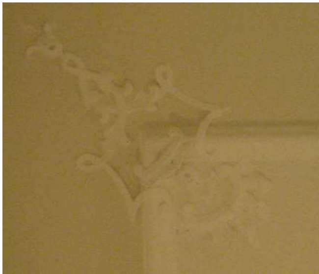
Abb. 151: Stuckdetail im Stiegenhaus von 1897
