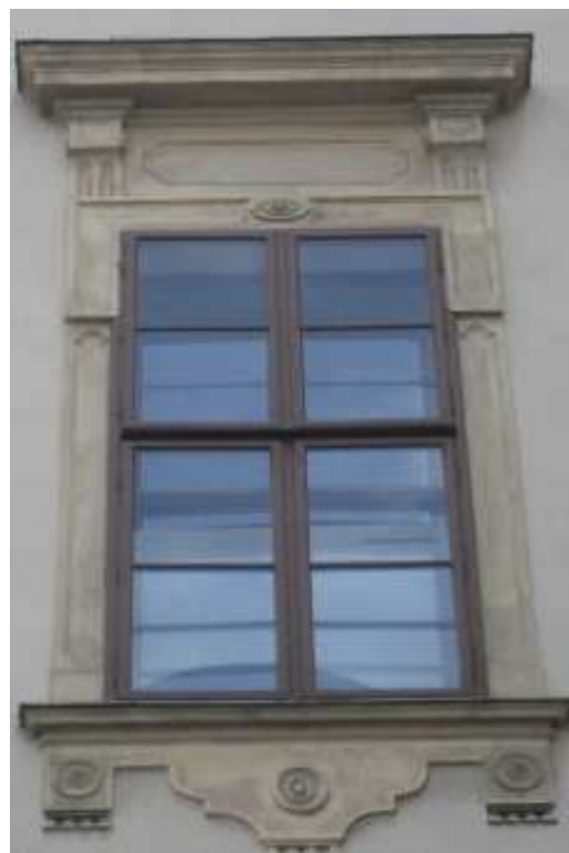
Abb. 57: Fenster des 2. Stockes an der Schaufflergassenfassade des Reichskanzleitraktes
