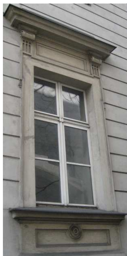
Abb. 156: 3. Beletagefenster, rückwärtige Fassade
