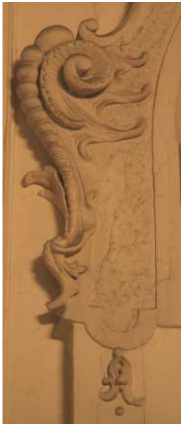
Abb. 104: Detail im Prunktreppenhaus
