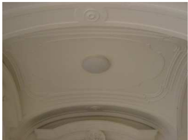
Abb. 97: Deckenstück im Vestibül
