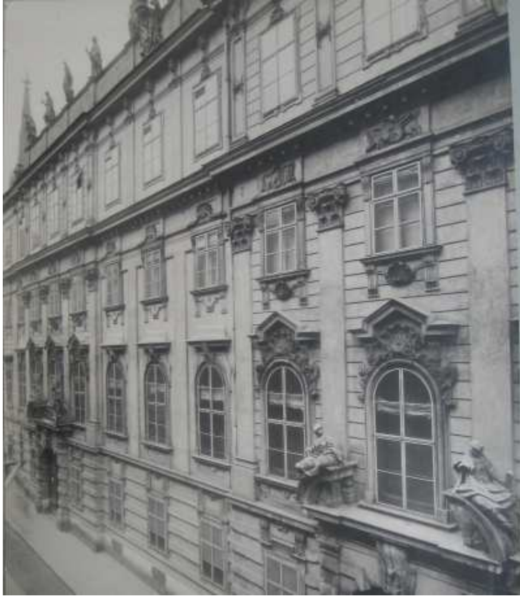
Abb. 80: Singerstrassenfassade und Attika, Wlha, Anfang des 20. Jh.
