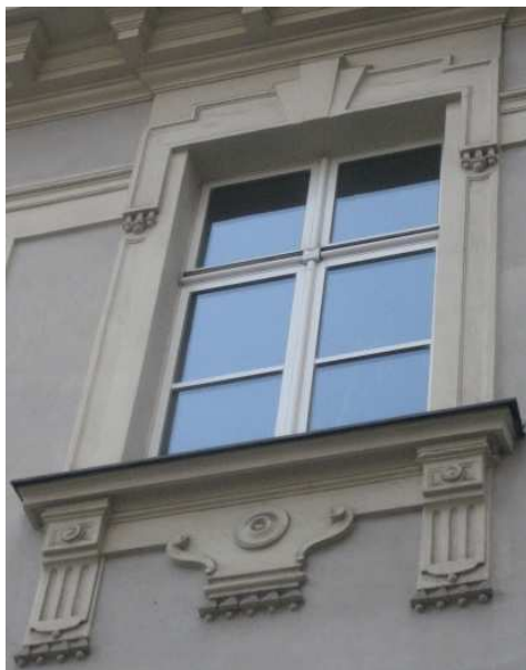
Abb. 158: 1. Mezzaninfenster, rückwärtige Fassade
