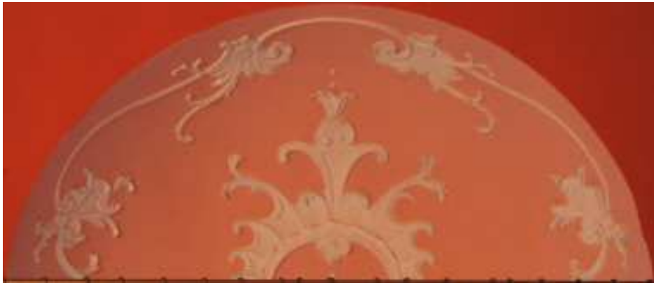
Abb. 127c: Fensterkalotte in Raumfolge des 1. OG rechts entlang des großen Innenhofes
