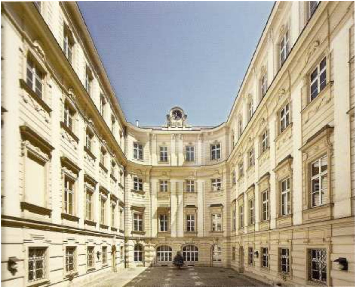
Abb. 85: großer Innenhof des Stadtbancogebäudes Richtung Stirnseite
