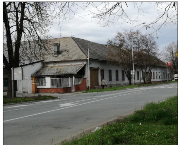
Abbildung 58: Strumpffabrik in Apatin; Quelle: eigene Aufnahme vom 06.04.2018.
