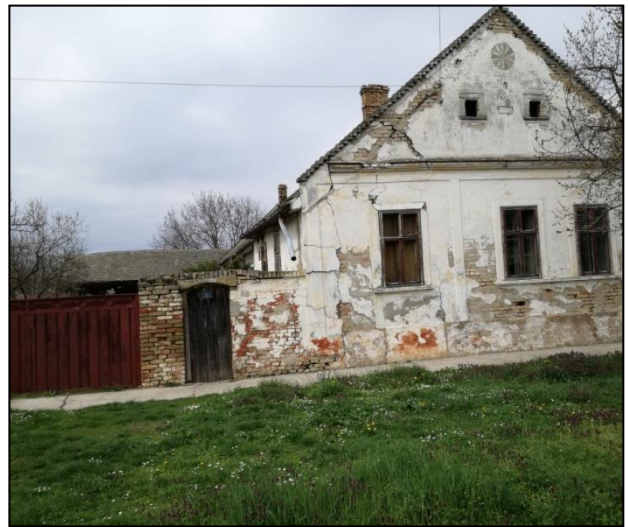
Abbildung 30: Haus Nr. 441 (siehe Abbildung 15) in der Kirchengasse; Quelle: eigene Aufnahme vom 06.04.2018.
