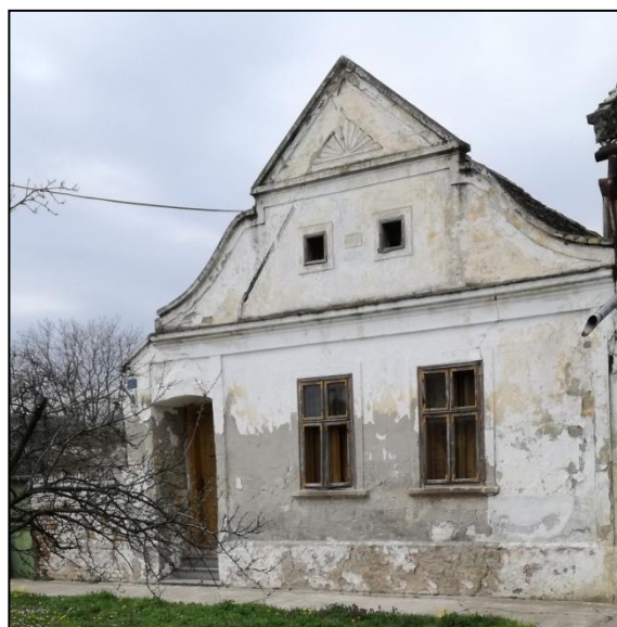
Abbildung 28: Haus Nr. 443 (siehe Abbildung 15) in der Kirchengasse; Quelle: eigene Aufnahme vom 06.04.2018.
