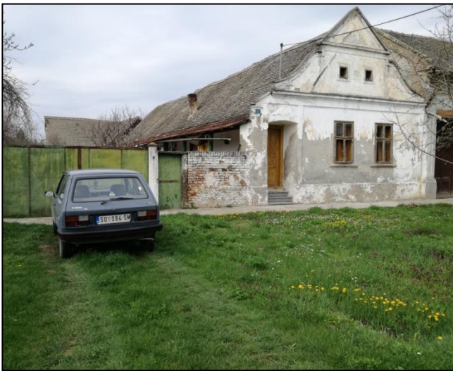
Abbildung 29: Haus Nr. 443 (siehe Abbildung 15) in der Kirchengasse; Quelle: eigene Aufnahme vom 06.04.2018.
