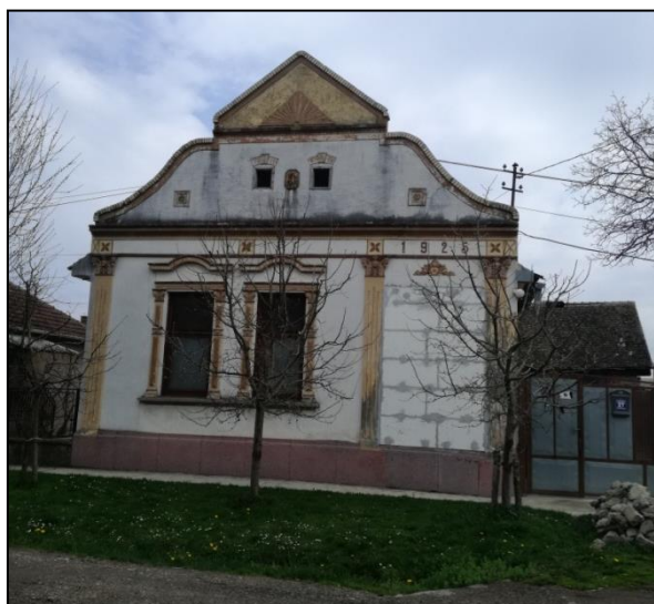
Abbildung 25: Haus Nr. 241 (siehe Abbildung 15) in der Böhmengasse; Quelle: eigene Aufnahme vom 06.04.2018.
