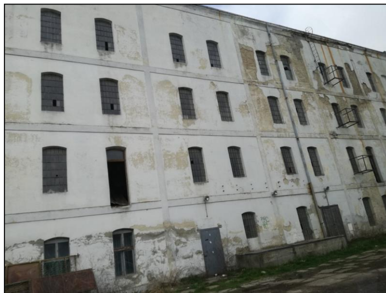
Abbildung 53: Ehemalige Dampfmühle in Filipowa; Quelle: eigene Aufnahme vom 06.04.2018.
