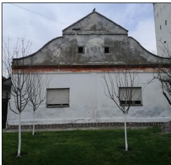
Abbildung 27: Haus Nr. 422 (siehe Abbildung 15) in der Kirchengasse; Quelle: eigene Aufnahme vom 06.04.2018.
