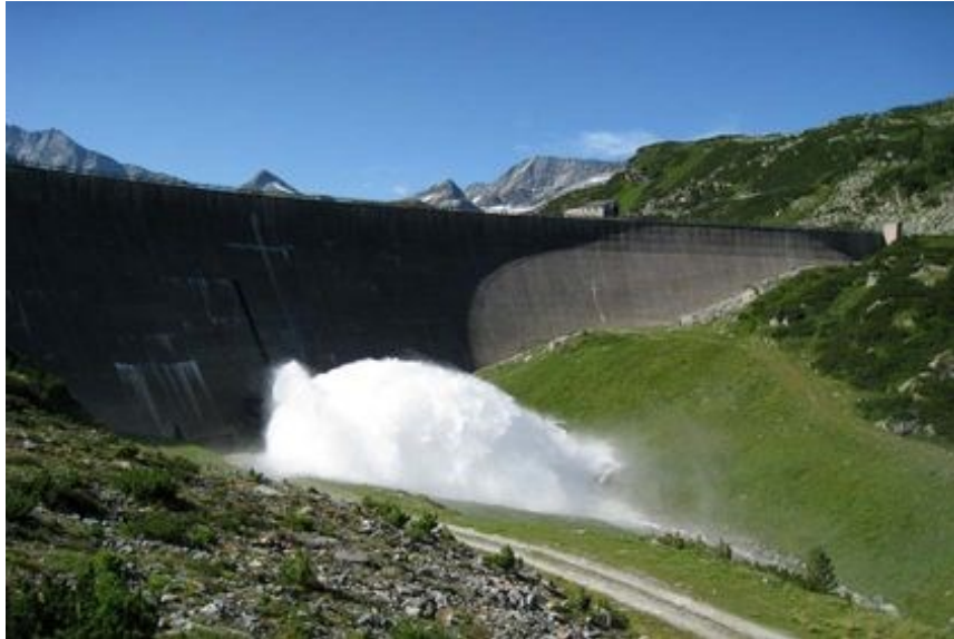
Abb. 31: Staumauer Tauernmoos (Stubachtal) mit geöffnetem Grundablass (ÖBB, Friedrich Lechthaler)
