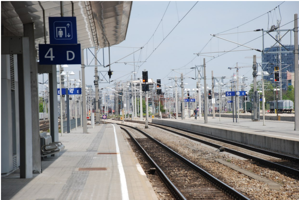
Abb. 13: Eisenbahninfrastruktur im Bahnhofsbereich Wien-Matzleinsdorf
