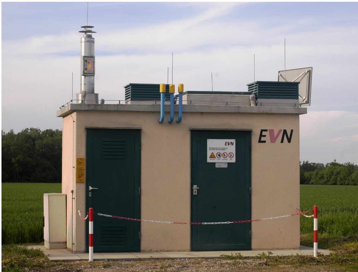
Abb. 17: Gasdruckregelstation von Hochdruck auf Mitteldruck, links ist der E-Schaltkasten zu erkennen (Wikipedia 2017a)
