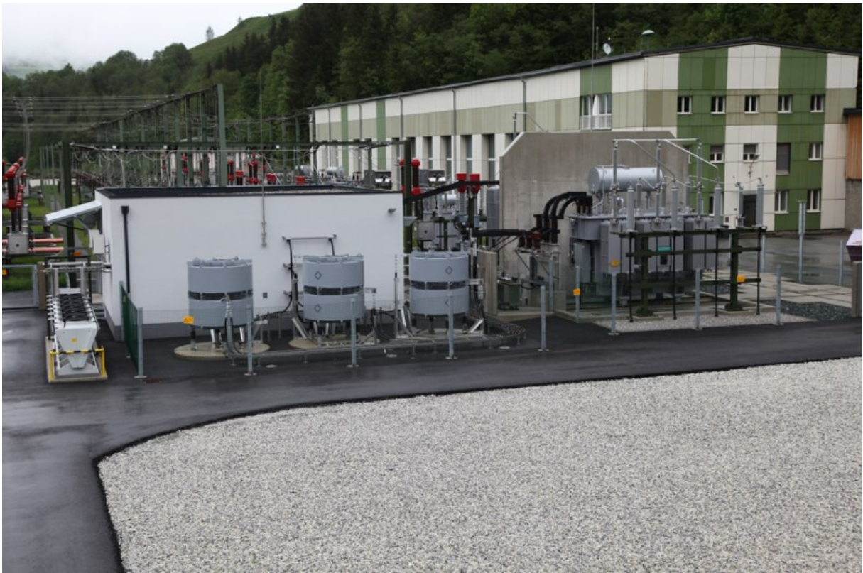
Abb. 29: Kraftwerk Uttendorf, im Hintergrund das Krafthaus mit der Leitwarte
