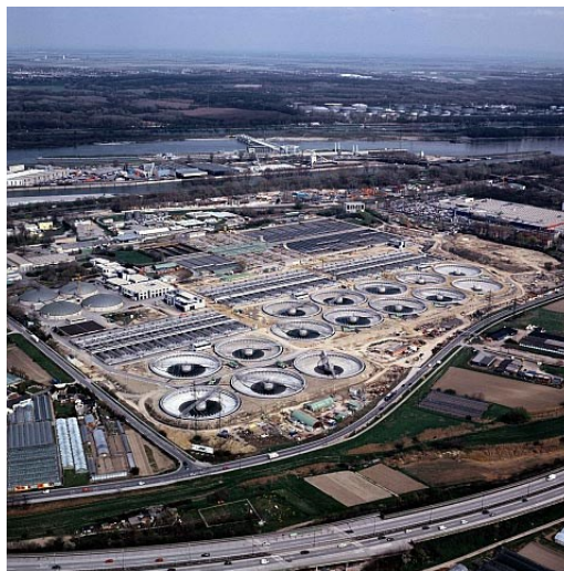
Abb. 11: Großkläranlage Wien Simmering (Stadt Wien 2017)
