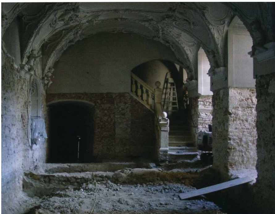
Abb. 22: Stift Rein, Ausgrabungsarbeiten in der Marienkapelle, romanische Sakristei, Kapitelsaal und Matutinstiege
