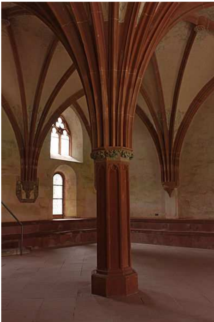
Abb. 33: Kapitelsaal Kloster Eberbach, Mittelstütze und Sternengewölbe aus dem 14. Jh.
