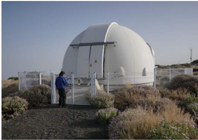
Abbildung 46 – 8 m-Baader Kuppel mit Beobachtungsspalt auf Teneriffa, Spanien [36]
