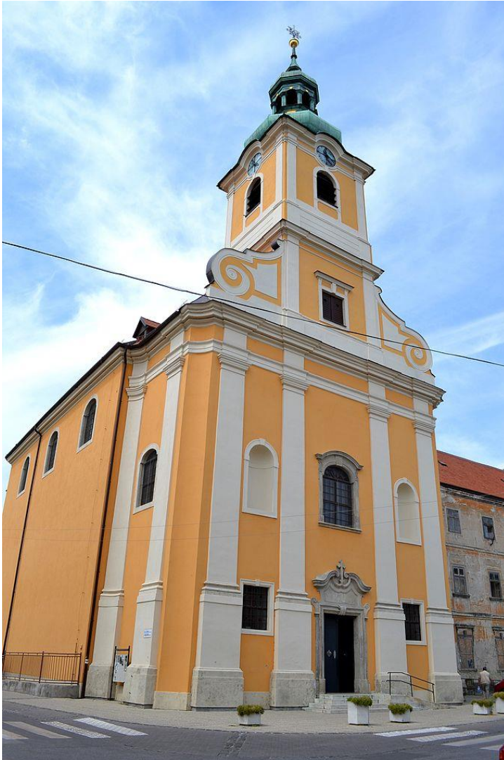
Abbildung 57: Šamorín (Sommerein), ehem. Paulanerkirche, Fassade.
