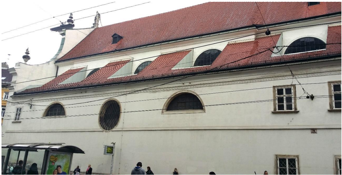
Abbildung 43: Wien, Paulanerkirche, Westfassade.
