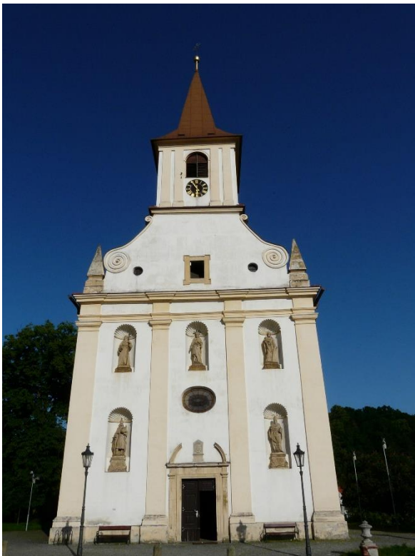
Abbildung 46: Namiest (Náměšť nad Oslavou), Pfarrkirche, Fassade.
