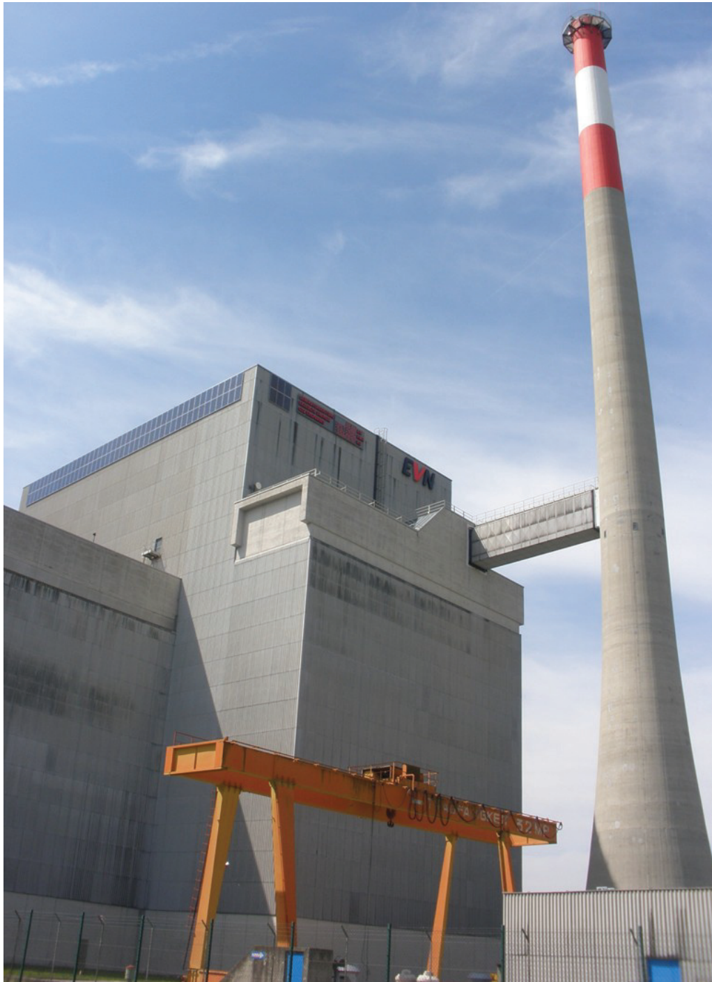
Abb. 1: Gegenwärtige Frontansicht des AKWs Zwentendorf im Tullnerfeld aus dem Jahr 2014. Seit 2009 wird von der EVN auf dem Kraftwerksgelände Strom aus Solarenergie produziert.
