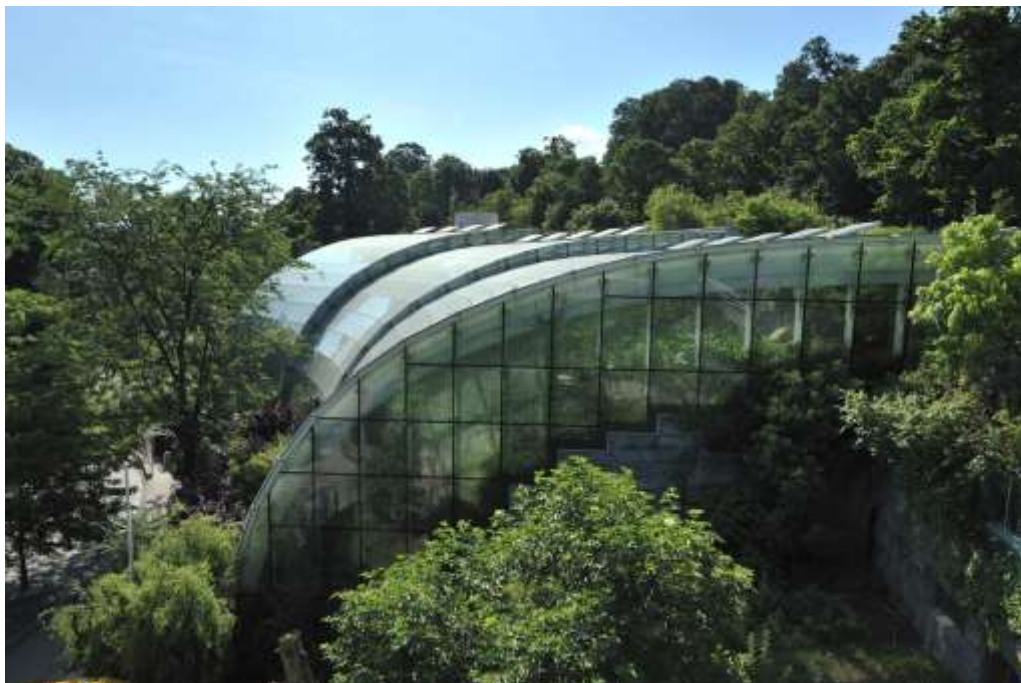
Abb. 2.2: Außenansicht des Regenwaldhauses im Tiergarten Schönbrunn (Foto H. Pechlaner, Tiergarten Schönbrunn)
