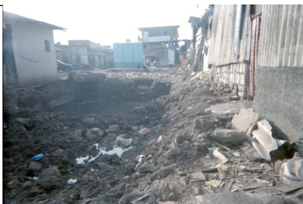
Figure 30: Sewage Disposal in Ambujwadi.
