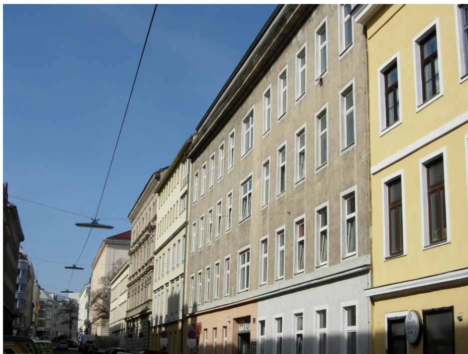
Abb.48: Wien-Fünfhaus, Zinckgasse, Richtung Goldschlagstraße (Zweites Haus von rechts: Zinckgasse 4)
