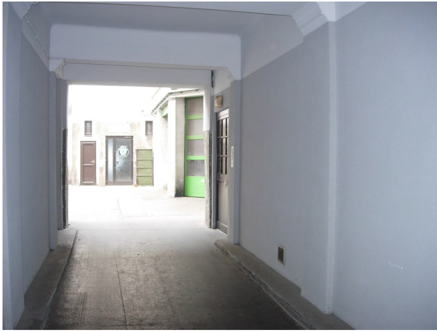
Abb.25: Wien-Fünfhaus, Neubaugürtel 37, Hauseingang, im Hof befindet sich heute eine KFZ-Werkstatt
