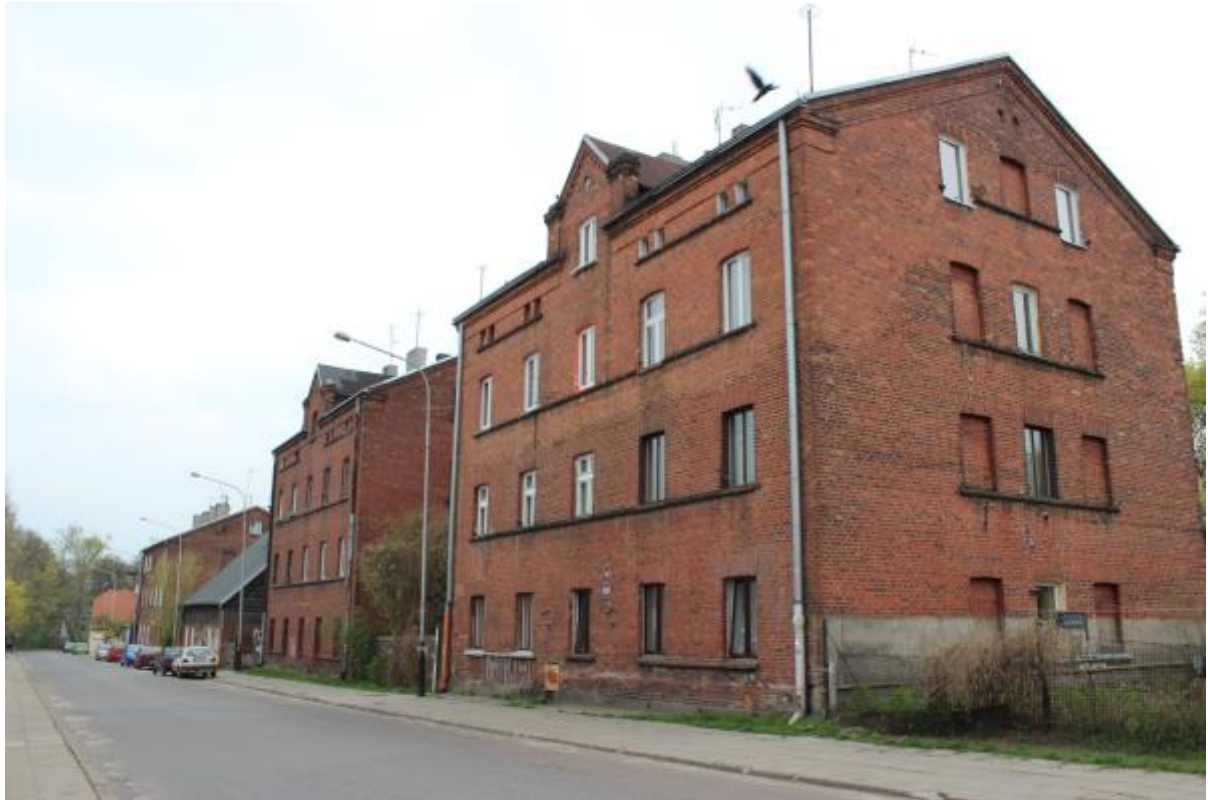
Abbildung 7: Ehemalige Arbeiterbaracken in " Księży Młyn"
