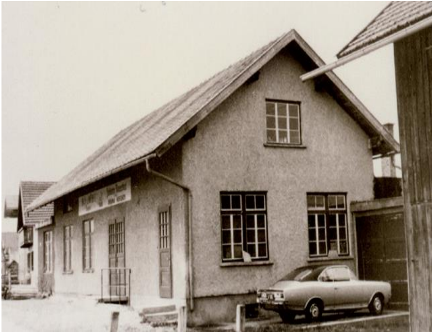
Abbildung 17: Bautischlerei Daxecker, heute ist dort die Sargfabrik. Jahr ?
