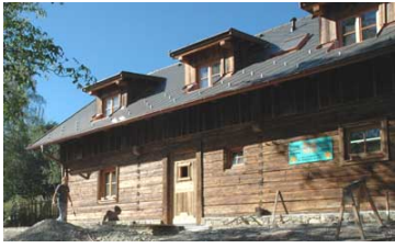
Das in „neu-alter Form“ errichtete „Nebengebäude“ auf Parzelle RA 3 dient nun als zweites Wohnhaus
