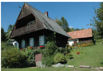
Siedlungsblockhaus aus 1928 mit dahinterliegendem ehemaligen Wirtschaftsgebäude
