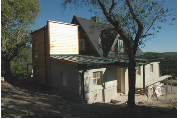
Gebäude RA 3, seitliche Aufnahme mit Kubusanbau
