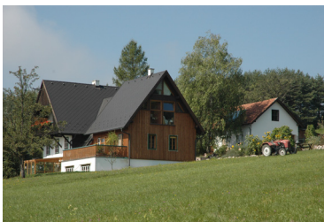
Zubau beim Gebäude RA 11, seitliche Aufnahme, dahinter ist das Nebengebäude
