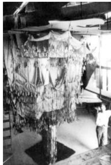
Abb. 67: Kettenmodell von Gaudí
