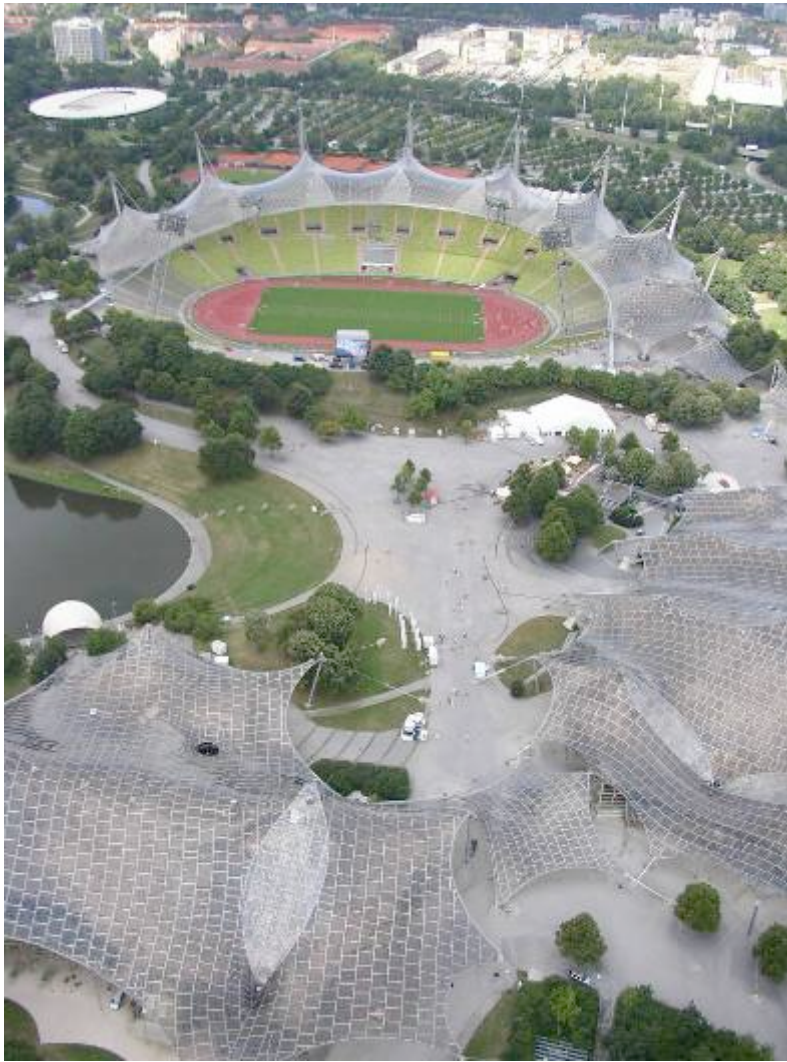
Abb. 70: Überdachung des Hauptsportstättenbereichs am Olympiagelände in München, Günter Behnisch und Frei Otto 1968-1972
