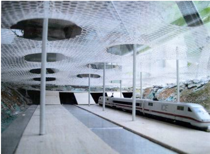
Abb. 44: Studie für zugbeanspruchte Gewölbeschale, Modell Nr. 59, Atelier Warmbronn 2001
