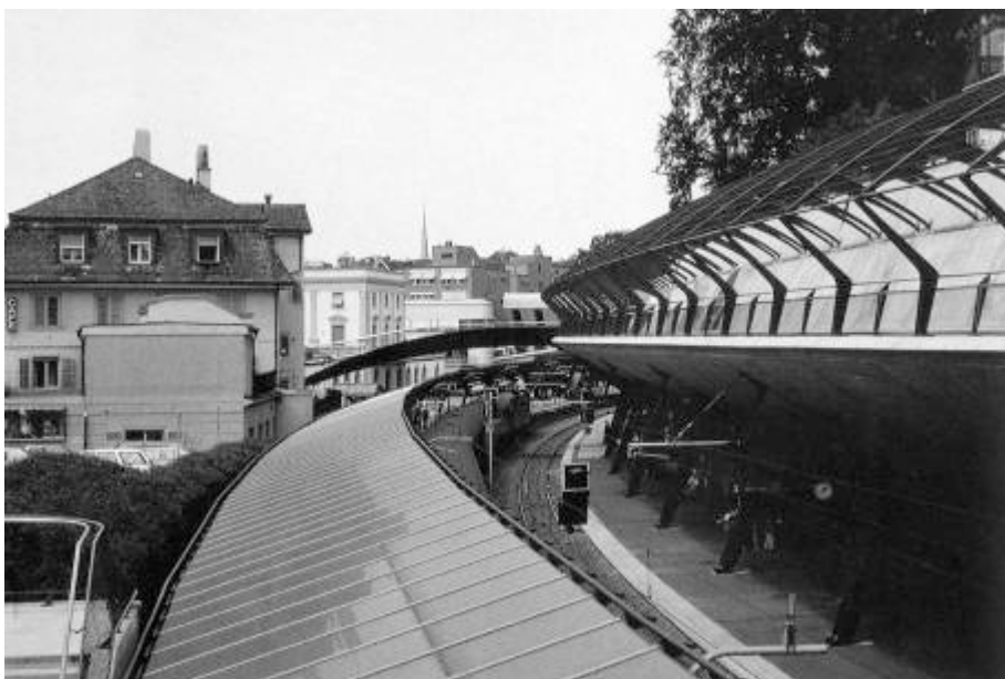
Abb. 9: Bahnhof Stadelhofen in Zürich, Außenansicht, Santiago Calatrava 1982-1990
