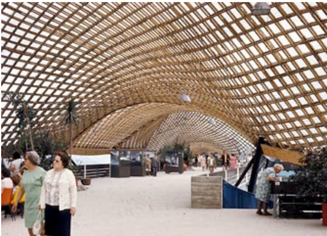
Abb. 69: Multihalle Mannheim Innen, Frei Otto 1975
