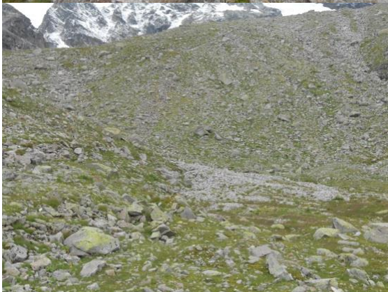
Abbildung 61: Murkegel im Auslaufbereich (Aufnahme: Guttmann 2016)
