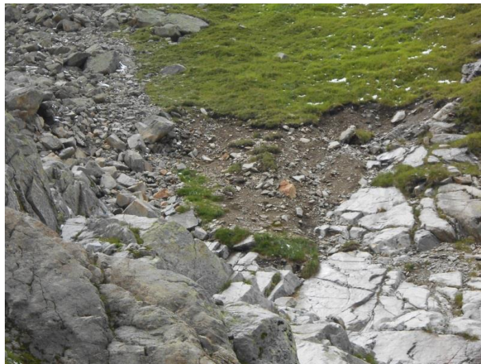
Abbildung 41: kleinräumige Rutschung im südwestlichen Untersuchungsgebiet (Aufnahmen: Guttman 2016)
