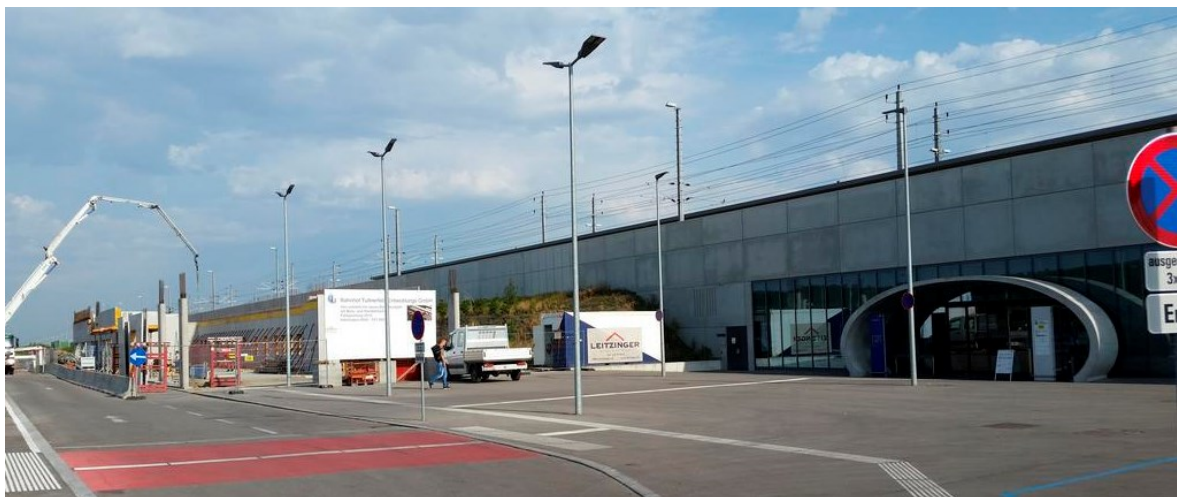
Abb. 37: Bahnhofsvorplatz mit Baustelle des Betriebsgebäudes, Blickrichtung Nordwesten (Quelle: PEISCHL 2015)
