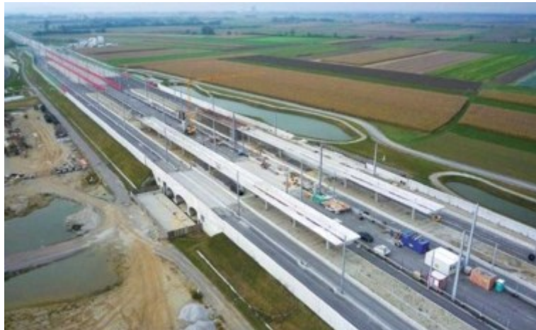
Abb. 35: Baustelle des Bahnhofs, Blickrichtung Nordwesten (Quelle: ÖBB o.J.)
