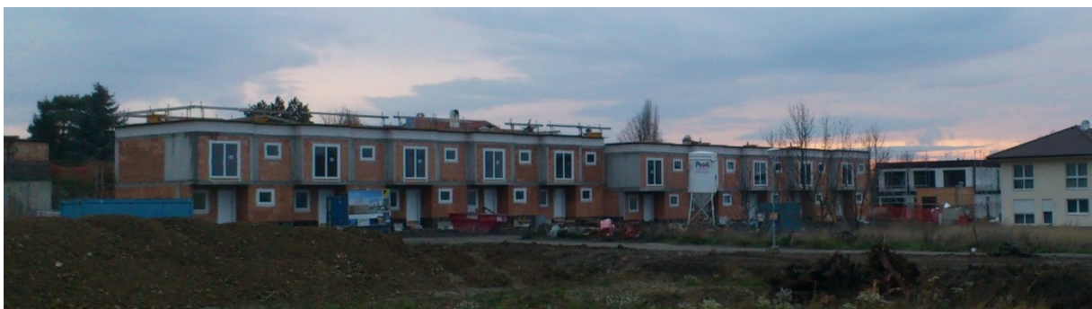
Abb. 28: Baustelle der Reihenhausanlage im Herbst 2015, Blickrichtung Nordwesten (Quelle: DONHAUSER 2015b)
