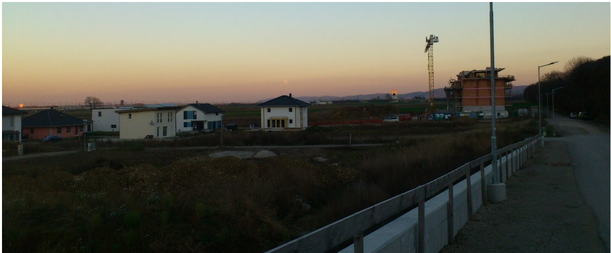
Abb. 30: Vorhaltefläche und Baustelle der Wohnhausanlage im Herbst 2015, Blickrichtung Osten (Quelle: DONHAUSER 2015c)
