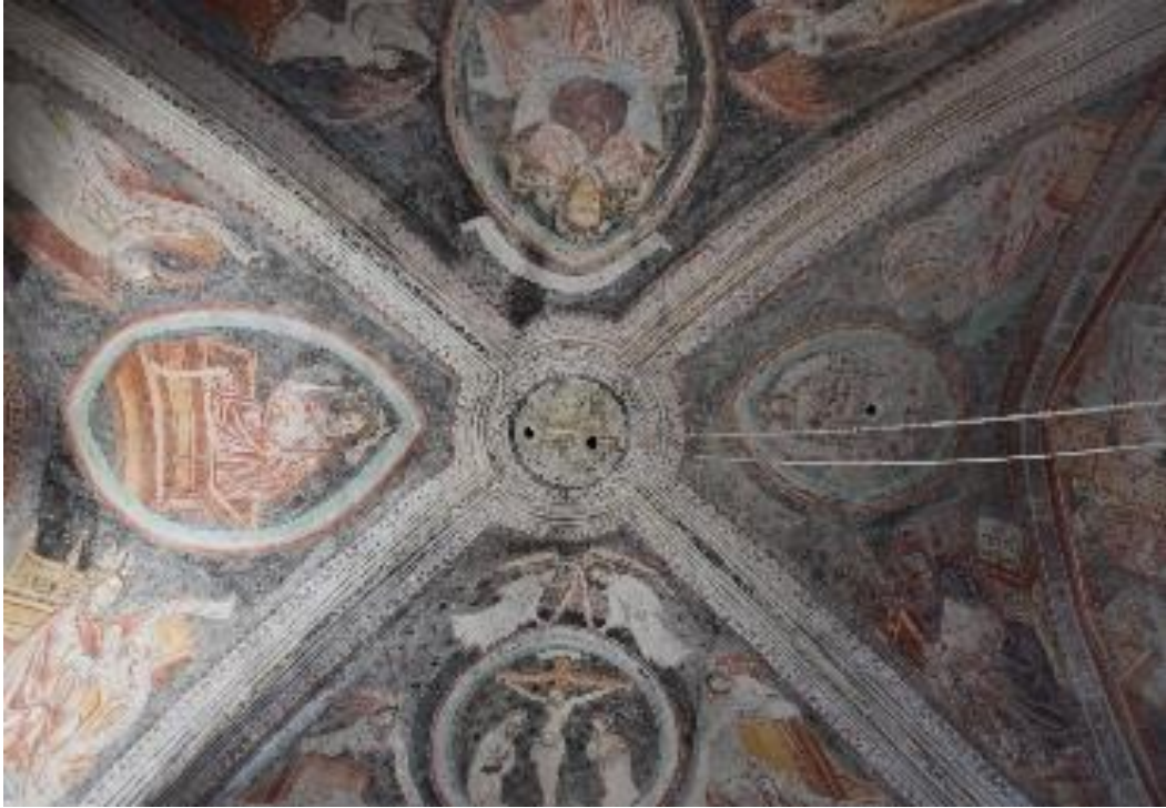
Abb. 104: Gewölbe, Chor, St. Nikolaus, Rojen, um 1400.
