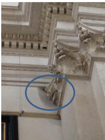
Abb. 69. Vertiefungen in der Mauer durch das nachträgliche Hineinschieben der Pfeiler in der Vierung, SS. Peter und Paul Kirche, Krakau.
