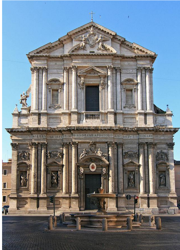
Abb. 92. Fassade, San Andrea della Valle, Rom.
