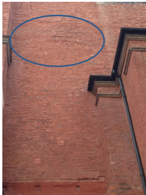
Abb. 61. Nordwand der SS. Peter und Paul Kirche, Spuren der zugemauerten Fenstern.
