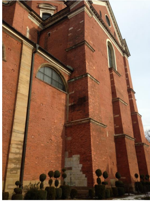
Abb. 64. Südwand, Transept der SS. Peter und Paul Kirche, niedrige Stützfeiler aus der Trevano Zeit.
