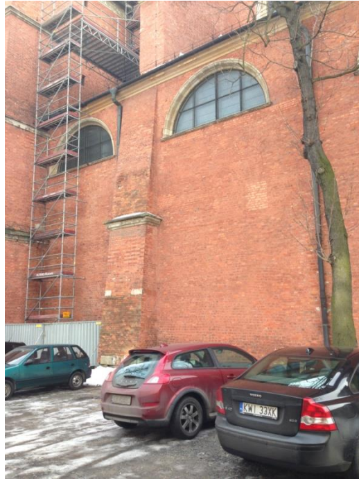
Abb. 62. Nordwand der SS. Peter und Paul Kirche, niedrige Stützpfiler von Bernardoni und Thermenfenstern aus der Trevano Zeit.
