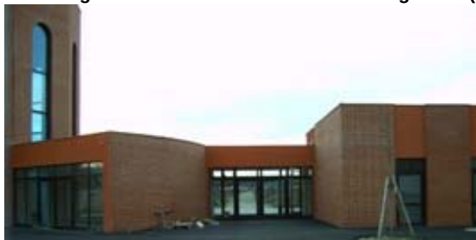
Abbildung 15 Verbindung vom Flachbau zur Verabschiedungshalle (während der Bauzeit)
