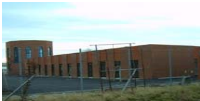
Abbildung 14 Blick auf Flachbau und Verabschiedungshalle (während der Bauzeit)
