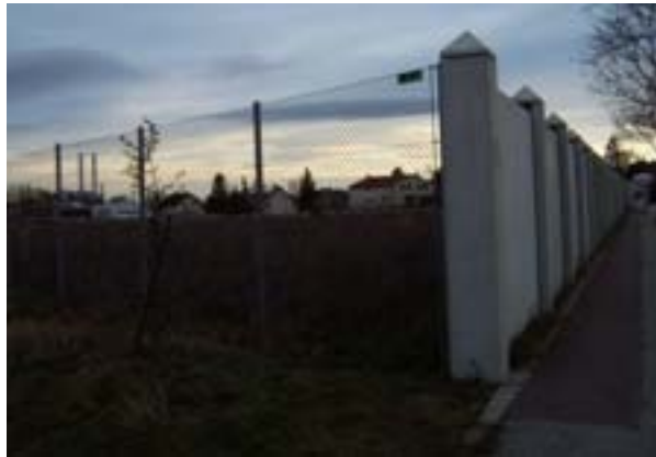
Abbildung 13 Ansicht: Friedhofsmauer in der Laxenburger Straße, stadtauswärts
