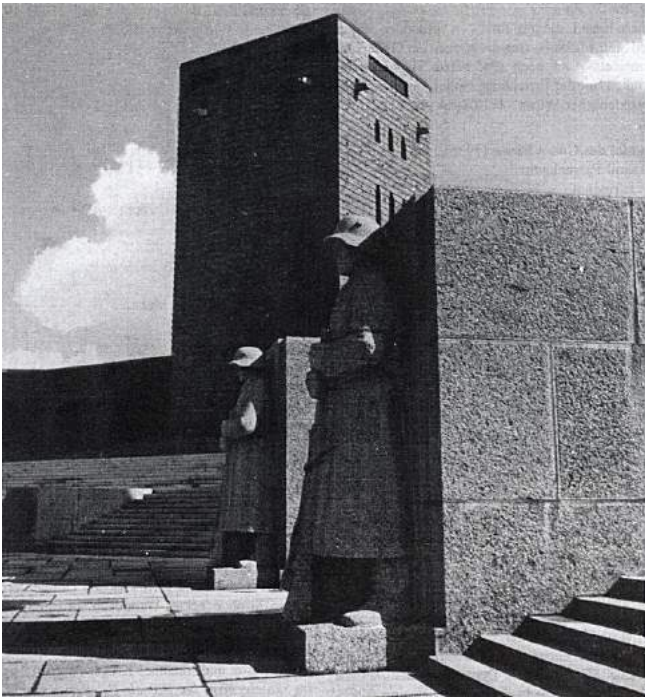
Abb.21 Walter und Johannes Krüger, Tannenberg-Denkmal bei Hohenstein (Polen), 1924-1927.
