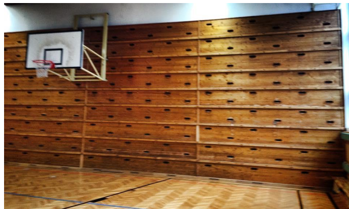
Abbildung 13: Turnsaalwand Gymnasium Bruck an der Leitha (eigene Aufnahme 24.10.2014)
